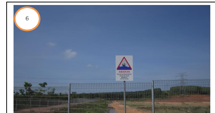
Kolam Takungan Banjir
