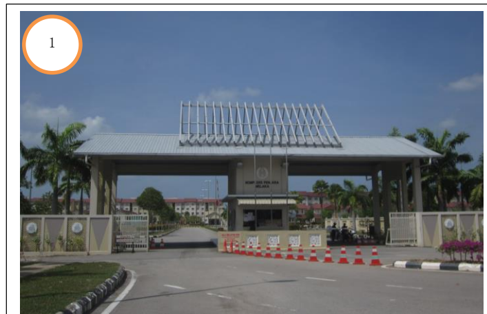
Kompleks Penjara Sg. Udang
