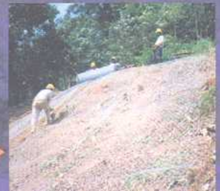
Jejaring keluli digunakan bagi memastikan pekerja-pekerja selamat semasa pembinaan cerun dijalankan.
