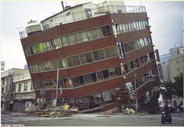
Bangunan pejabat yang rosak teruk dalam gempa bumi di Kobe, Jepun pada 1995 (gambar: Roger Hutchinson)
