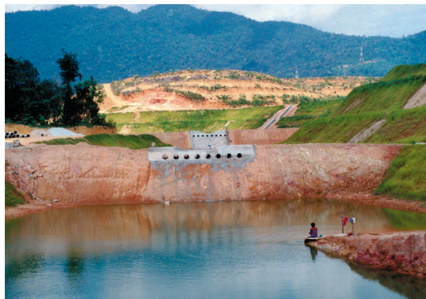
Gambarfoto 4.2 : Sistem Perangkap Mendap Yang Cepak Photo 4.2 : Efficient Silt Trap System
