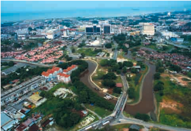
Gambarfoto 5.1 : Sg. Melaka-Program Pencegahan dan Peningkatan Kualiti Air Sungai Photo 5.1 : Sg. Melaka-River Pollution Prevention and Water Quality Improvement Programme
