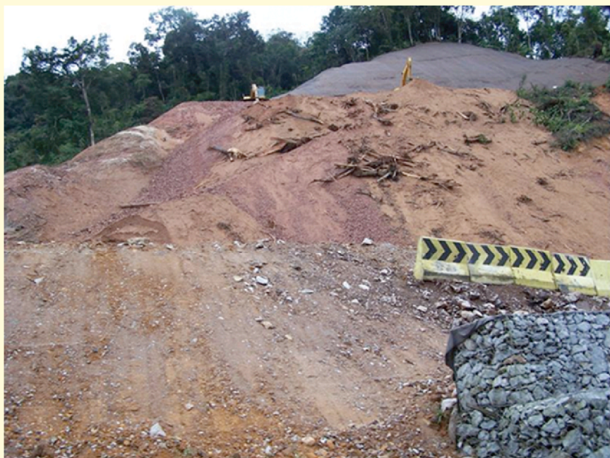
Projek Pembangunan di Kawasan Tanah Tinggi Development Project on Highland Areas
