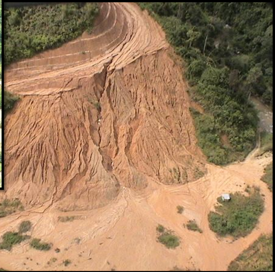
Foto : Jalan Masuk Lokasi 2, Ke Projek CSN, ASPAC & ACOMAX, Oktober 2008
