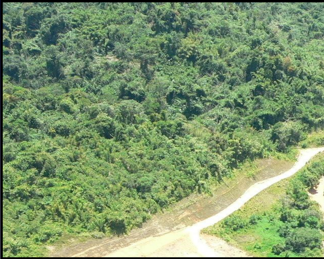
Foto : Jalan Masuk Lokasi 1, Ke Projek CSN, ASPAC & ACOMAX, Oktober 2008
