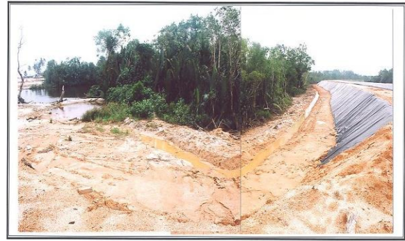
Earth drain yang telah dibina untuk mengelakan lumpur masuk ke sungai
