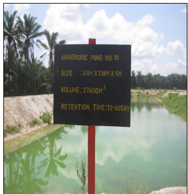
Plat 3.8 : Kolam Anaerobik yang dibina untuk merawat sisa efluen yang dijana oleh Kilang Kelapa Sawit
