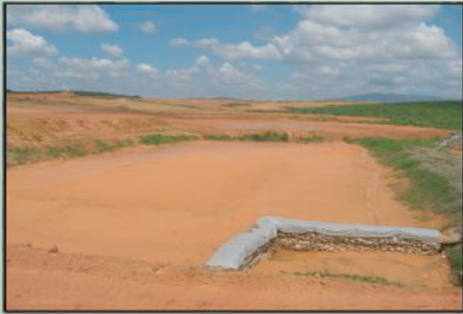
Plat 3.2 : Kolam perangkap mendap tidak diselenggara dengan sempurna
