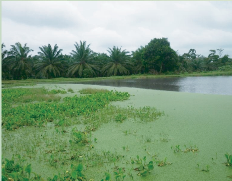
Plat 3.11 : Sistem Pengolahan Effluen (Sistem Kolam) Yang Tidak Diselenggara Dengan Baik
