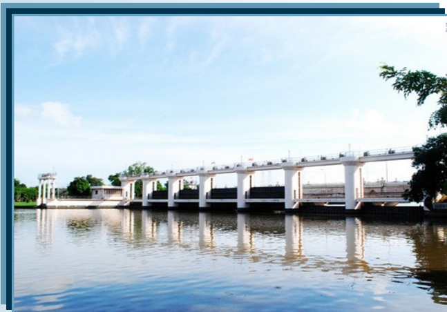
Lokasi Sungai di Ampangan Jajar, Mergong
