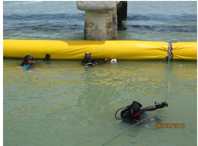
Gambarfoto 5.4: Pasukan SCUBA sedang memeriksa keadaan Silt Curtain
