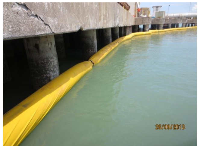
Gambarfoto 5.2: Silt Curtain dipasang di kawasan pembinaan untuk kawalan air marin
