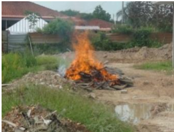
Gambarfoto 2.2: Pembakaran terbuka dilakukan di tapak pembinaan
