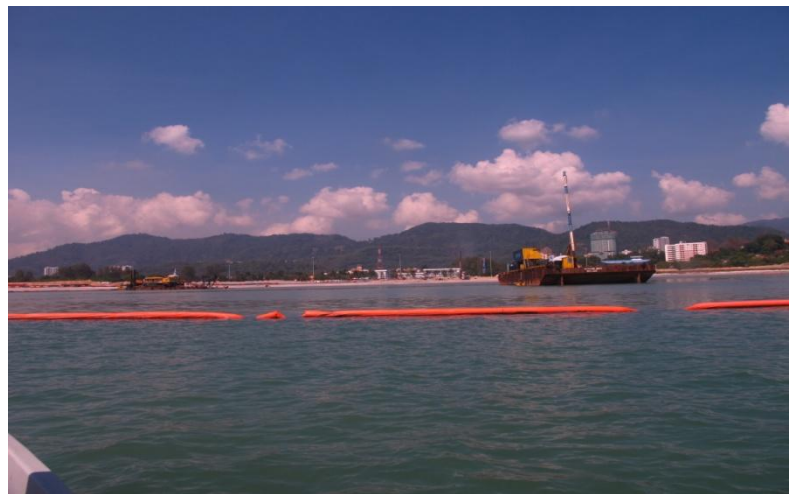
Gambarfoto 7.3: Silt Curtain yang dipasang di perairan projek penambakan tanah
