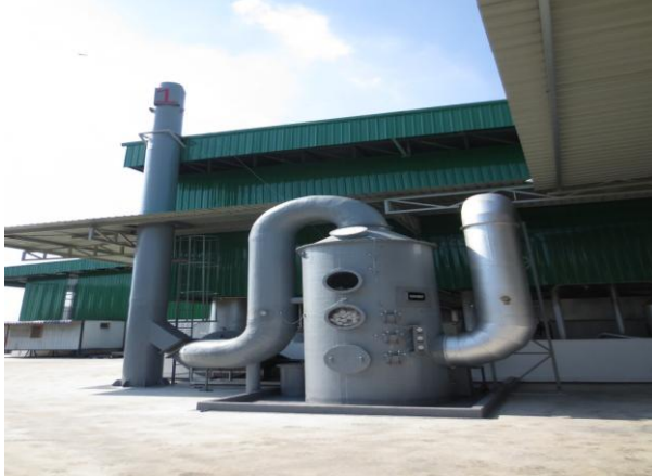
Gambarfoto 4.5: AKPU Penggahar (Scrubber) untuk merawat gas berasid
