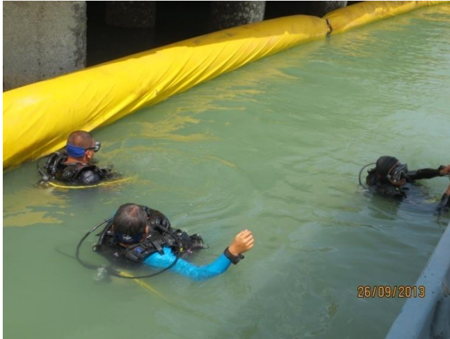
Gambarfoto 5.3: Pasukan SCUBA menjalankan selaman untuk memeriksa keadaan Silt Curtain yang dipasang
