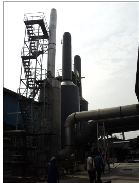
Gambarfoto 3.5: Pemeriksaan scrubber di premis Lee Rubber Co. (Pte.) Ltd.
