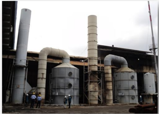
Gambarfoto 5.6: Alat kawalan pencemaran scrubber yang telah dibaiki dan dipasang dengan instrumen pengawasan prestasi
