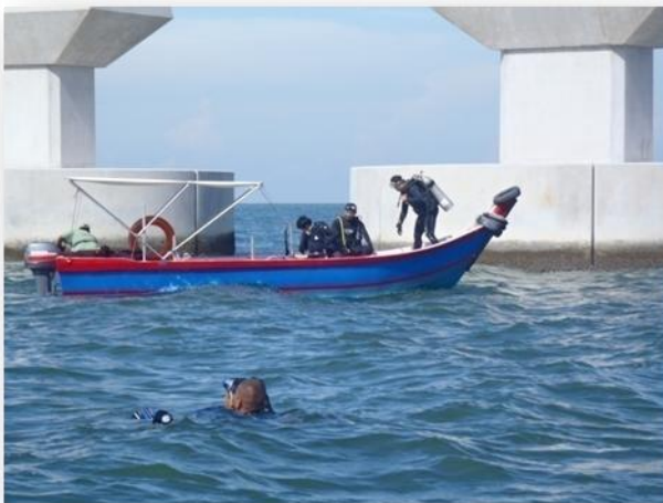
Gambarfoto 5.13: Pasukan SCUBA menjalankan selaman untuk memeriksa dasar laut di sepanjang kawasan pembinaan jambatan
