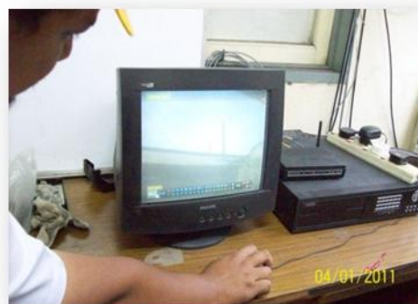
Gambarfoto 5.8: Pemasangan CCTV di premis memudahkan pemantauan secara berterusan dijalankan
