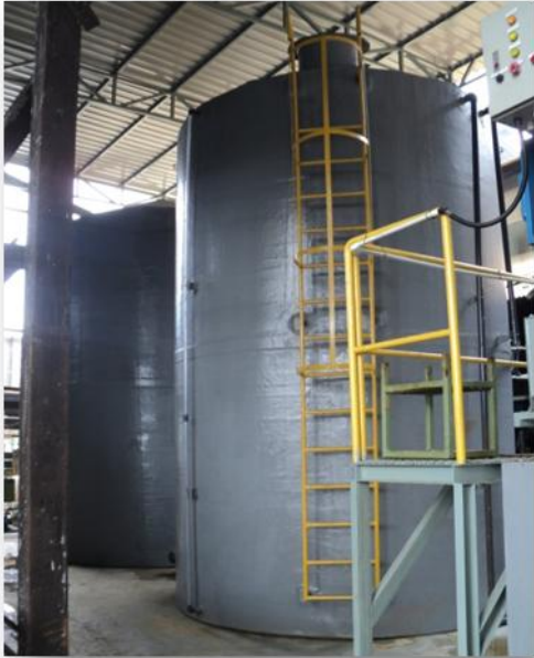
Gambarfoto 5.5: Dua unit tangki simpanan efluen yang baru ditambah
