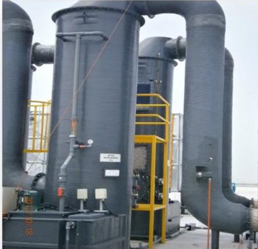
Gambarfoto 4.5: AKPU- Penggahar (Scrubber) untuk merawat gas berasid
