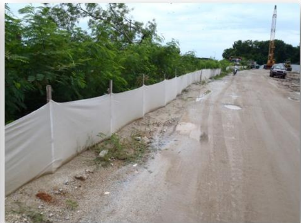
Gambarfoto 5.14: Silt fence dipasang di kawasan pembinaan darat untuk kawalan air larian
