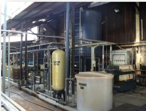
Gambarfoto 5.3: Sistem pengolahan efluen perindustrian yang telah dinaik taraf
