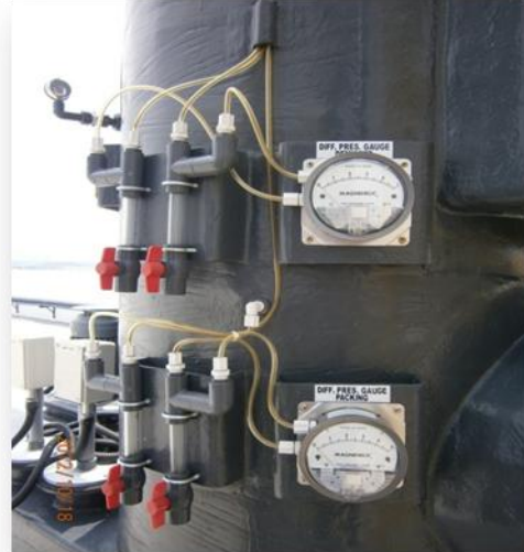
Gambarfoto 4.6: Magnehelic Gauge dipasang bagi memastikan sistem penggahar beroperasi dengan baik
