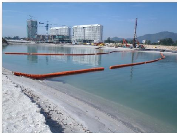
Gambarfoto 5.19 : Dua lapisan Silt curtain yang dipasang di kawasan tambakan laut
