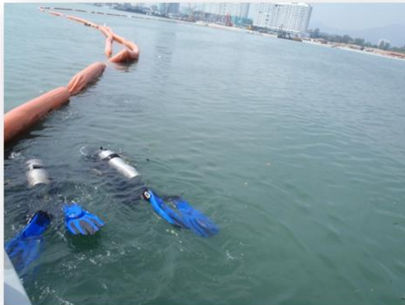
Gambarfoto 5.17 : Pasukan SCUBA menjalankan selaman untuk memeriksa keadaan silt curtain yang dipasang
