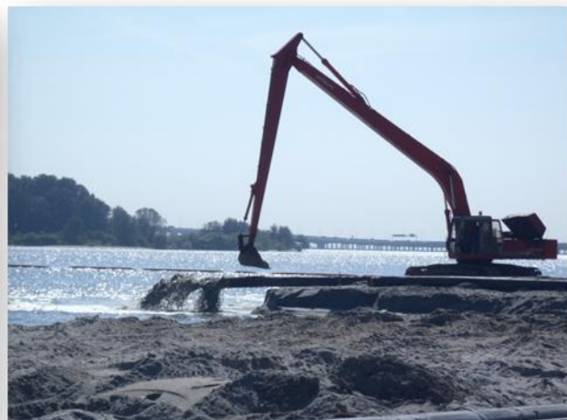
Gambarfoto 5.20 : Aktiviti penambakan laut aktif dijalankan di tapak pembinaan
