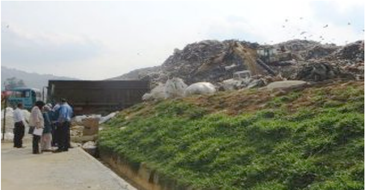
Pemeriksaan Ke Tapak Pelupusan Sampah Pajam, Pada 18 September 2013 Inspection at Pajam Landfill on 18 September 2013
