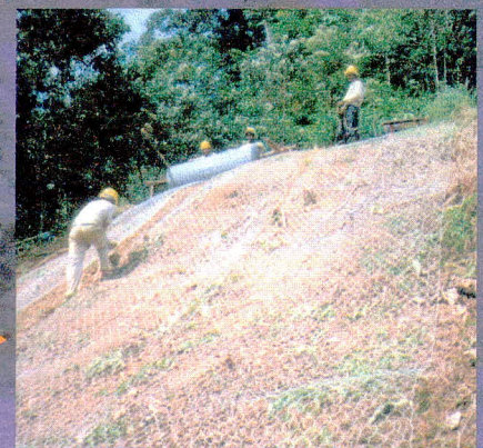
Jejaring keluli digunakan bagi memastikan pekerja-pekerja selamat semasa pembinaan cerun dijalankan.
