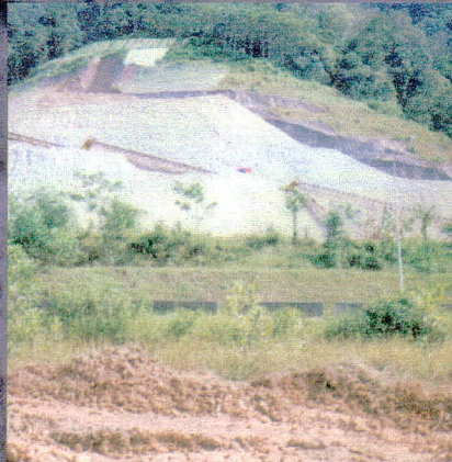
Cerun runtuh dibaik pulih menggunakan timbunan batu-batu menutup bahagian yang telah runtuh dan mengekalkan kestabilan
