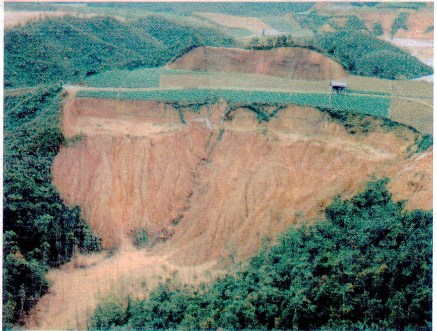
Runtuhan tanah di cerun curam
