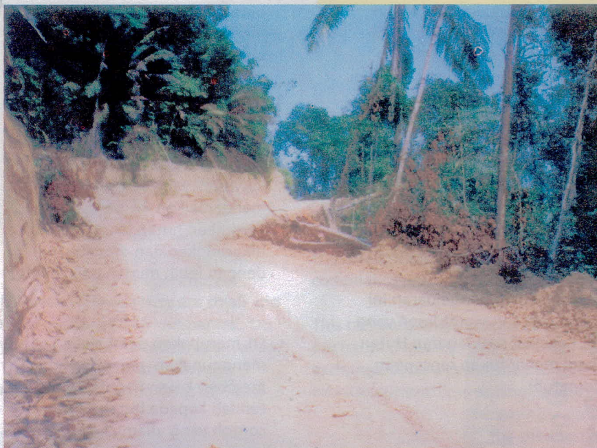
Rajah 5 : Jalan tuju yang digunakan bagi mengeluarkan balak dari kawasan lesen
