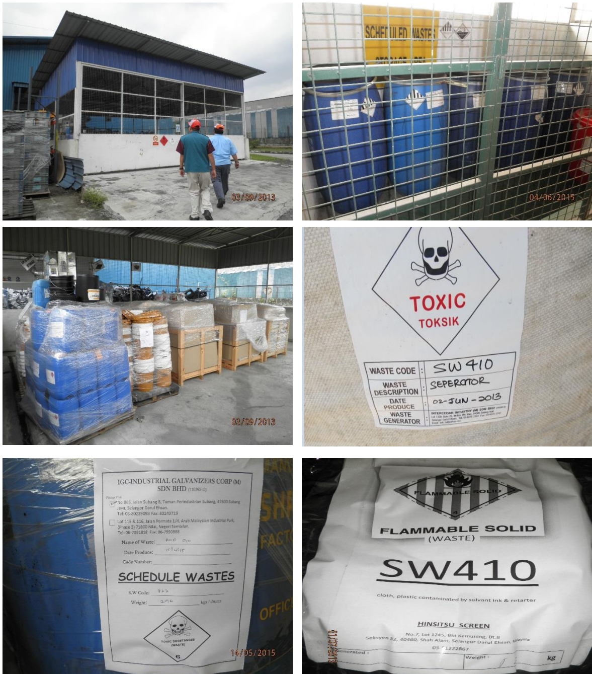
Foto 4.2 : Penstoran Dan Pelabelan Buangan Terjadual Yang Baik
