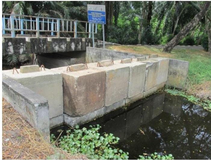
Foto 4.8 : Check Dam Yang Telah Siap Dibina Di Johan Setia Klang Yang Membekalkan Dan Mengekalkan Air Untuk Melembabkan Kawasan Tanah Gambut
