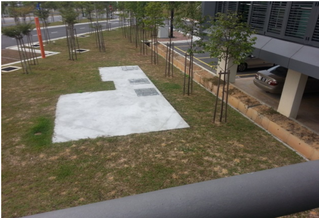
Sistem Penguraian Air Hujan (SPAH) di bawah tanah diaplikasikan di Pusat Rehabilitasi PERKESO untuk menjimatkan penggunaan air. Air yang ditakung digunakan untuk tujuan siraman pokok-pokok di pusat tersebut.
