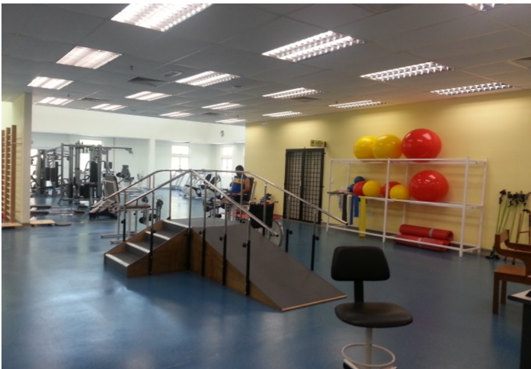
Penggunaan mentol cekap tenaga di dalam bangunan Pusat Rehabilitasi PERKESO untuk menjimatkan penggunaan tenaga elektrik
