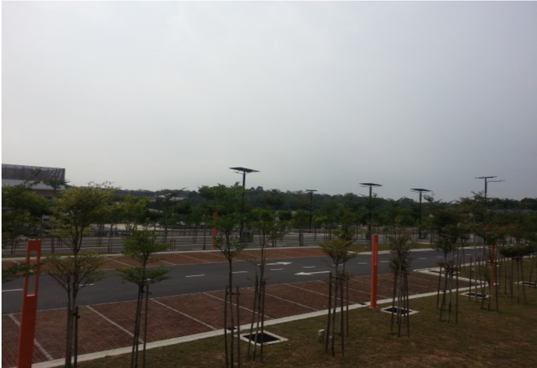
Pemasangan solar panel di “street lighting” di Pusat Rehabilitasi PERKESO untuk menjimatkan penggunaan tenaga elektrik
