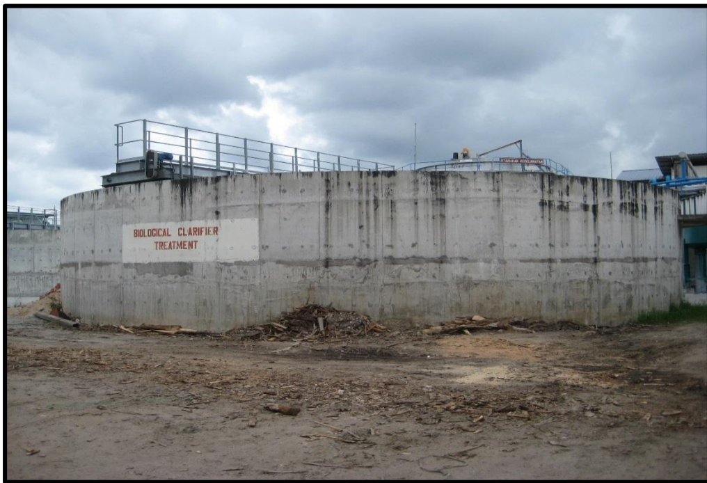
Gambar 3.9 : Pemeriksaan Sistem Pengolahan Efluen Perindustrian – Biological Clarifier
