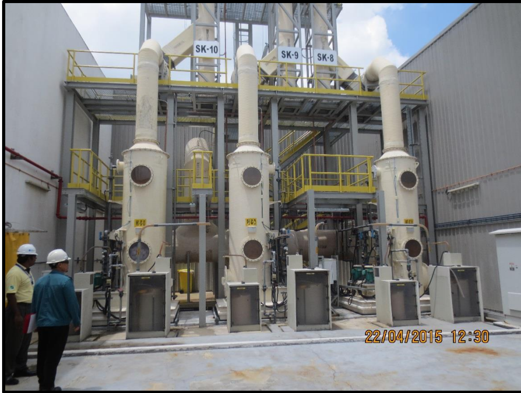
Gambar 3.2 : Pemeriksaan bagi Alat Kawalan Udara – Scubber
