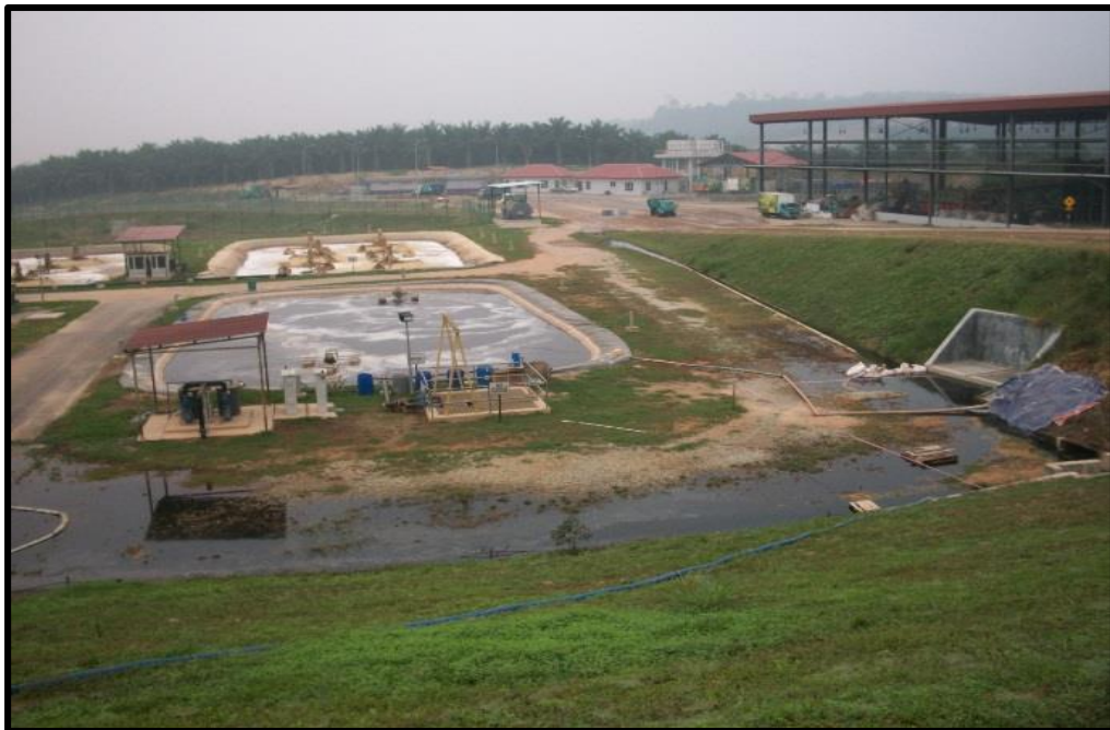
Gambar 3.11 : Pemeriksaan ke atas Loji Pengolahan Air Larut Resapan di Tapak Pelupusan Sampah (Sanitari)
