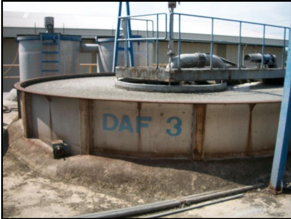
Gambar 3.8 : Pemeriksaan Sistem Pengolahan Efluen Perindustrian – Unit DAF
