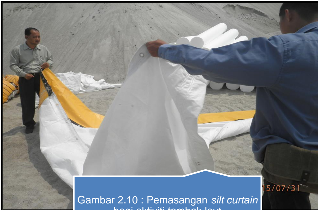
Gambar 2.8 : Silt curtain sebagai langkah kawalan bagi aktiviti tambak laut
