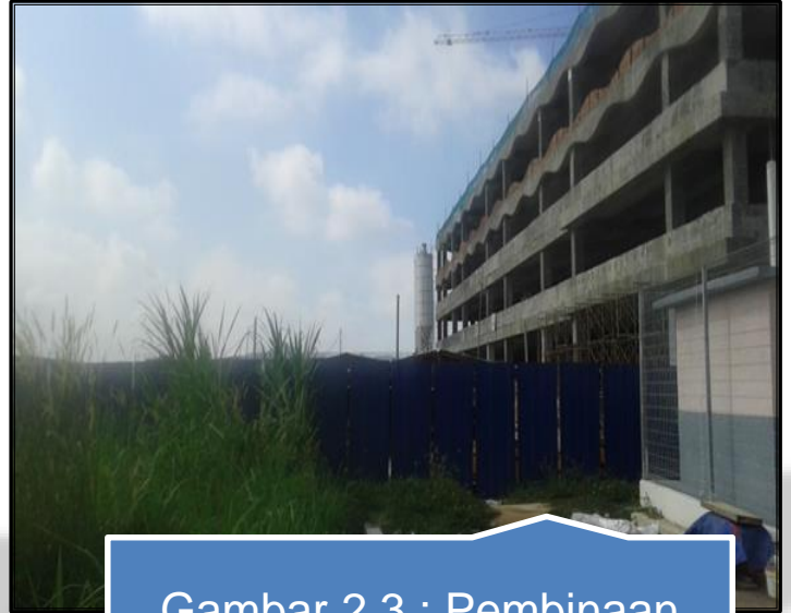
Gambar 2.3 : Pembinaan hotel dan servis apartment
