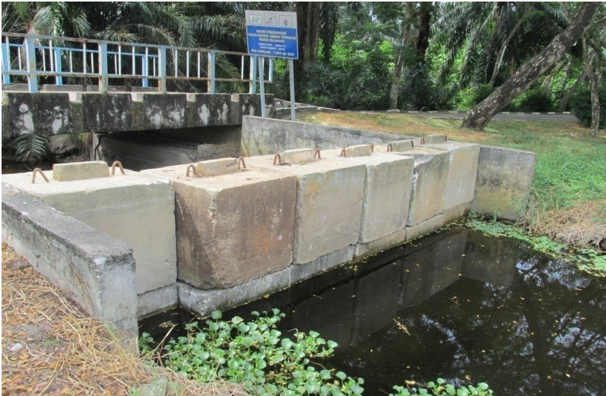
Foto 4.6 : Pembinaan check dam di Sungai Kandis, Jalan Kebun, Klang.
