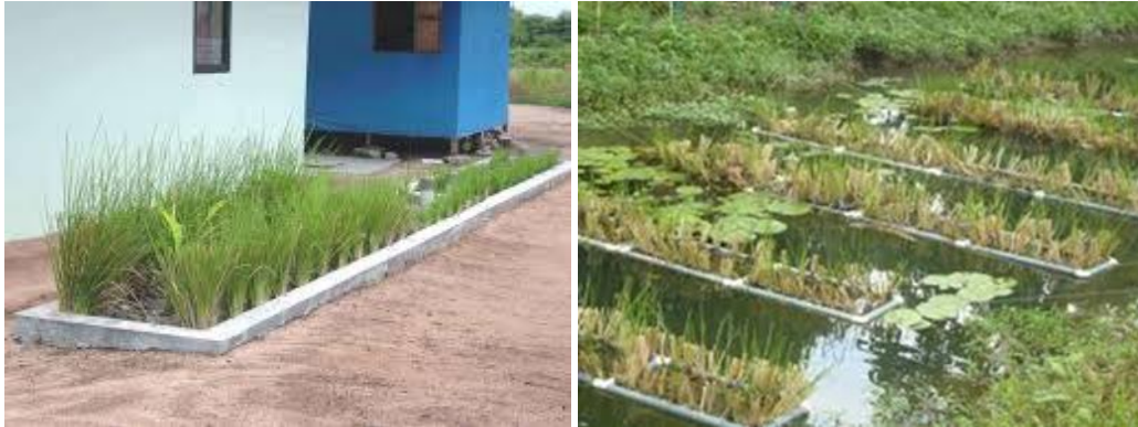
Gambarajah 14: Contoh sistem rawatan tanah lembap buatan
