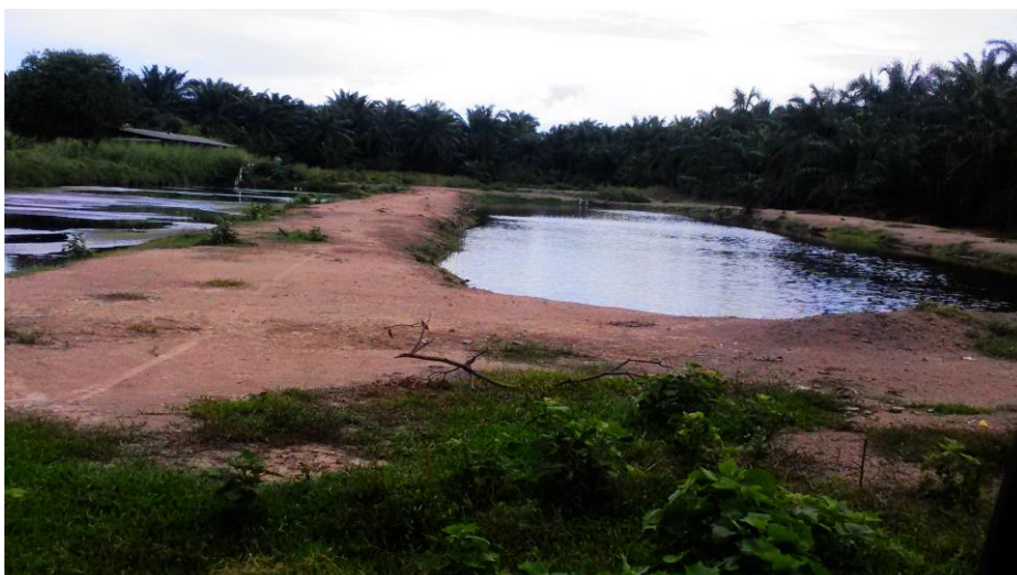
Gambarajah 5: Contoh kolam anaerobik
