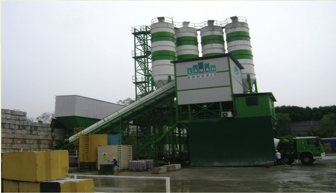
Gambar 3(g): Lawatan bagi permohonan alat kawalan pencemaran udara (bagfilter) di Laman Konkrit
