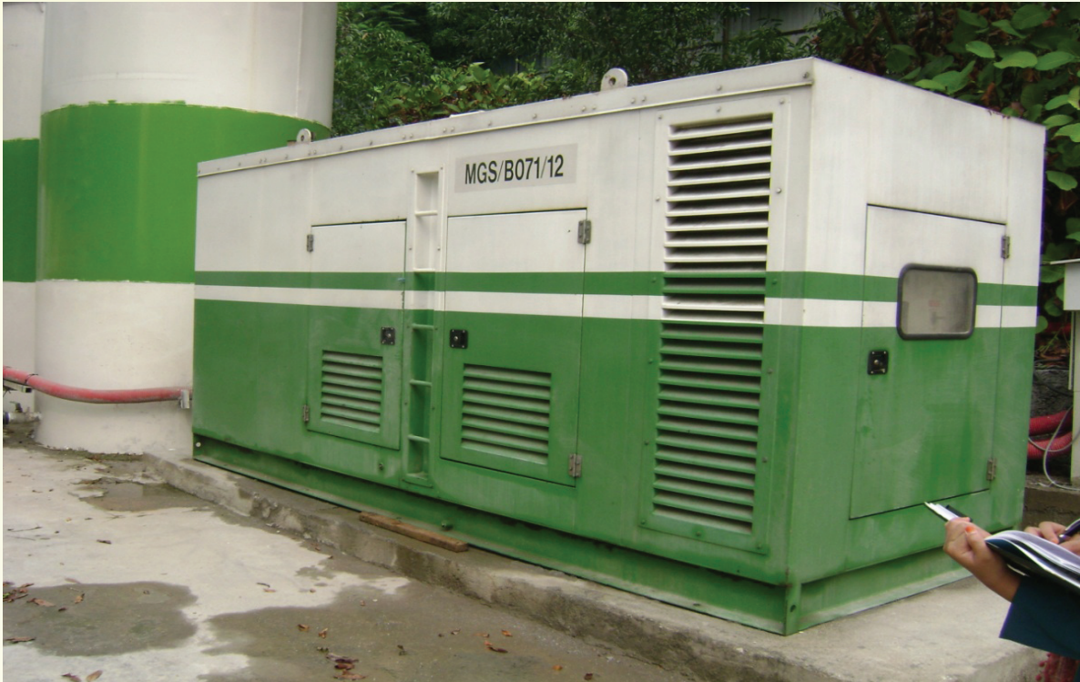
Gambar 3(i) : Penempatan satu (1) unit Janakuasa tunggu sedia di premis Laman Konkrit
