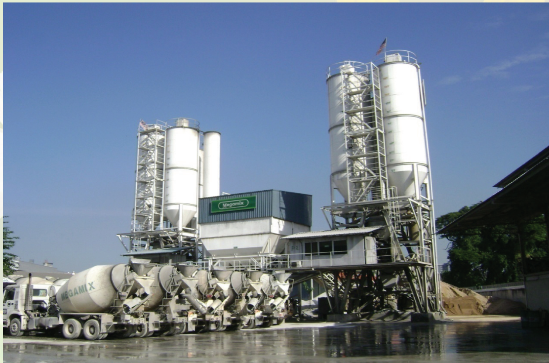
Gambar 3(d): Lawatan Tapak bagi Permohonan Alat Kawalan Pencemaran Udara (Bag Filter) di loji pembancuh konkrit Megamix
