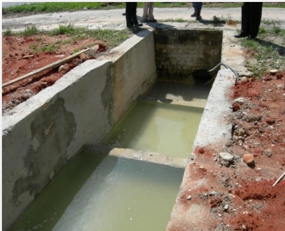
“Silt trap” sebagai langkah bagi mengawal kelodakan
