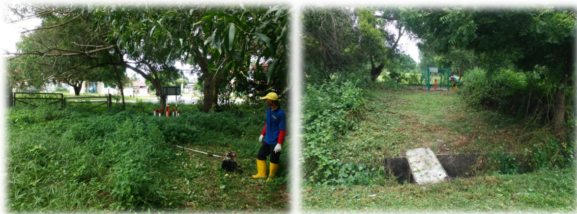
Gambar foto 4.3 Kelantan: Kerja-kerja penyelenggaraan telaga air bawah tanah.
