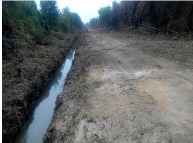
GAMBARFOTO 3: FIREBREAK YANG DIBINA DARIPADA PARIT JEJARI SEDIAADA YANG BOLEH DIGUNAKAN OLEH PIHAK BOMBA UNTUK OPERASI PEMADAMAN (DIRAKAM PADA 24/04/2016)
