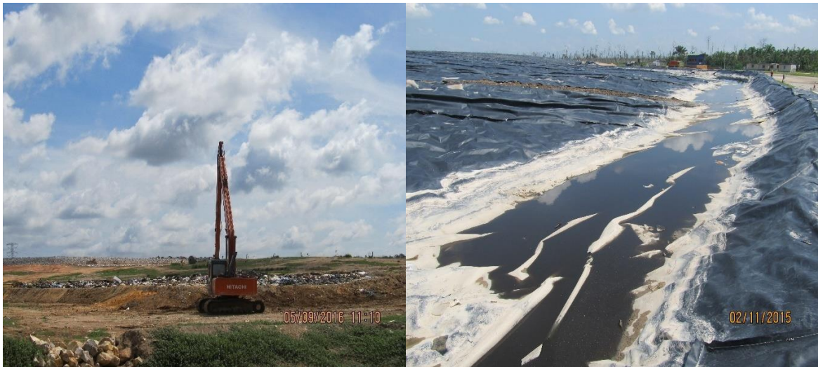
Foto 3.3: Antara tapak pelupusan sisa pepejal yang terdapat di Negeri Selangor termasuk di bawah seliaan Pihak Berkuasa Tempatan
