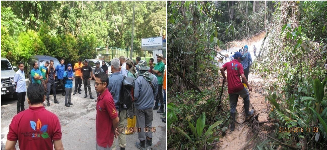
Foto 3.2 : Lawatan Ke Tapak Projek Pembangunan Bersama Agensi Teknikal
