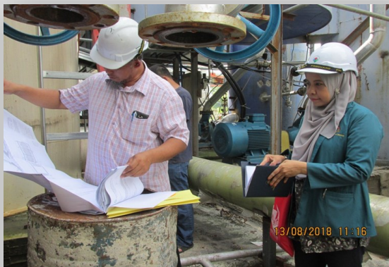
Lawatan Verifikasi As-Built oleh Jabatan Alam Sekitar Perlis, OCISB & Cekal Environmental Services di Kawasan Perindustrian Kuala Perlis pada 13 Ogos 2018
