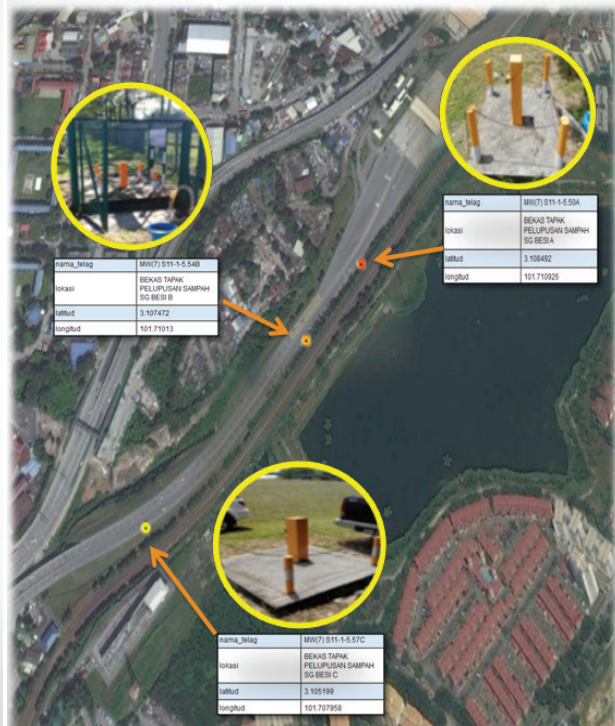
STESEN AIR BAWAH TANAH DI PARLIMEN SEPUTEH HIGHWAY MEX KUALA LUMPUR MW(7)S11-1-5.50 A ,MW(7)S11-1-5.57 B DAN MW(7)S11-1-5.57 C
