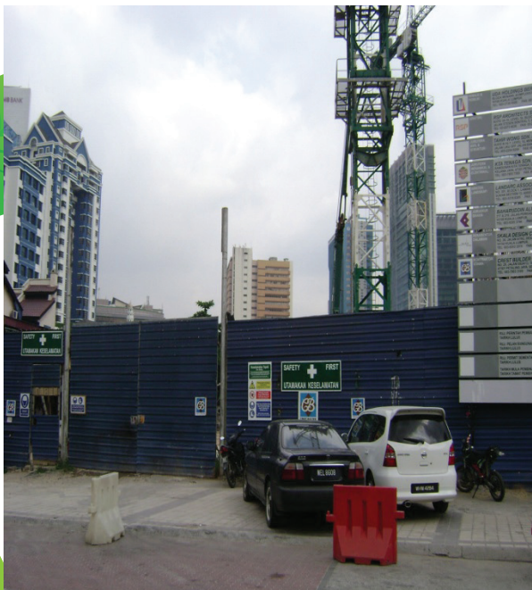
Gambar 3(e) : Lawatan Tapak bagi semakan zon penampian di lokasi cadangan projek jenis pembangunan bercampur
