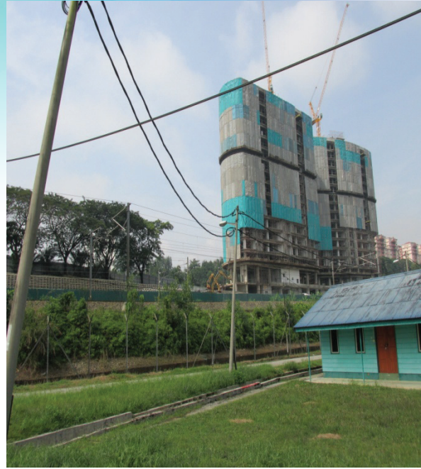
Lawatan tapak bagi semakan zon penampakan di lokasi cadangan projek EIA
