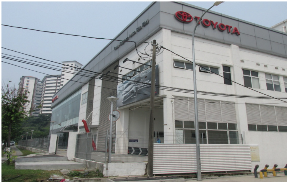
Lawatan tapak bagi jenis permohonan PAT di tapak bangunan sedia ada
