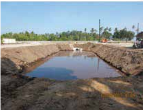
Peralatan kawalan hakisan tanah bagi mengawal air larian permukaan dari aktiviti kerja tanah perlu diselenggara
