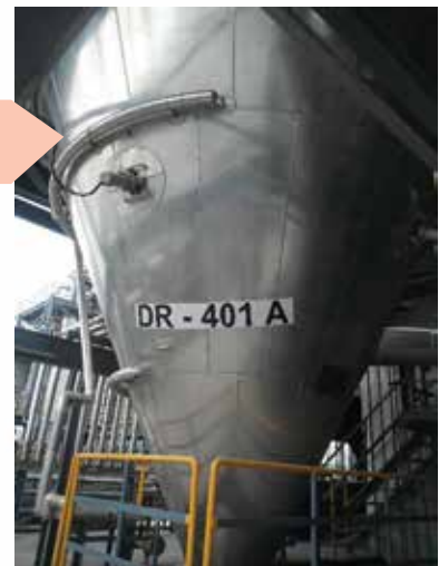
Alat Perangkap Habuk Empar (Outlet Cyclone)
