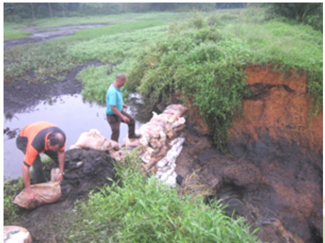
Gambar 4.3 JAS Negeri Johor: Langkah kawalan yang diambil ketika berlakunya kejadian benteng kolam pecah
