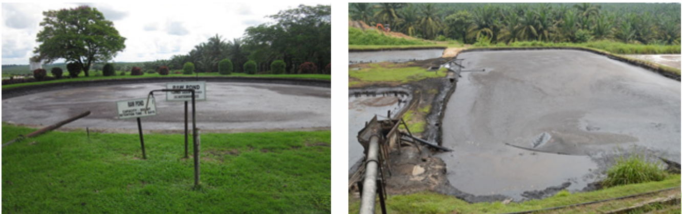
Gambar 4.1 JAS Negeri Johor: Ponding system di kilang kelapa sawit bertujuan untuk merawat POME
