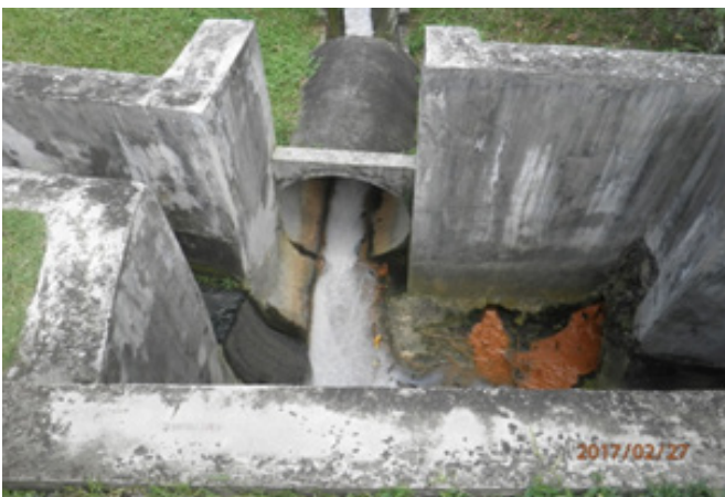
Gambar 4.8 JAS Negeri Johor: Pelepasan efluen yang tidak dirawat sepenuhnya terus ke longkang awam
