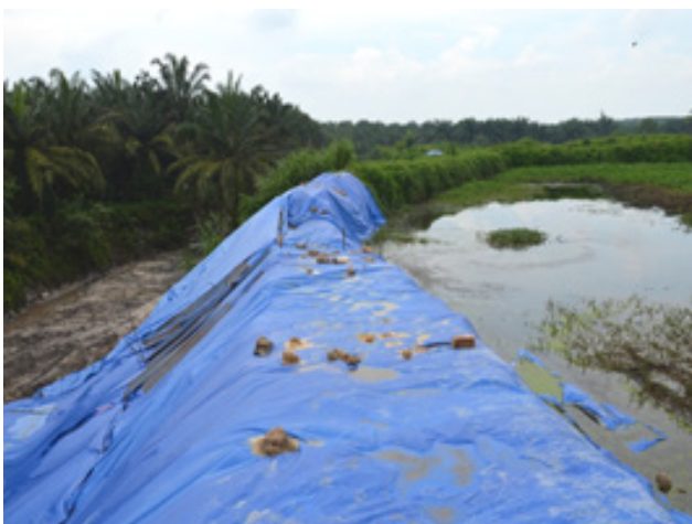
Gambar 4.3 JAS Negeri Johor: Langkah kawalan yang diambil ketika berlakunya kejadian benteng kolam pecah
