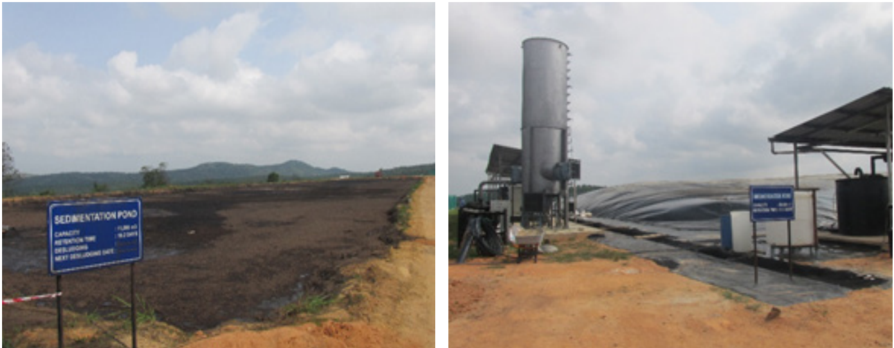
Gambar 2 : Keadaan sedimentation pond dan Biogas Reactor yang terdapat di Kilang Kelapa Sawit Daerah Kota Tinggi
