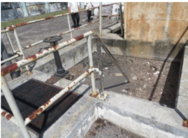
Gambar 1: Keadaan loji pengolahan kumuhan yang tidak diselenggara dengan baik
