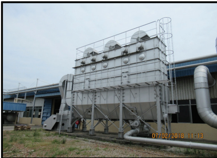
Gambar 7 : Siasatan penguatkuasaan ke atas Alat Kawalan Pencemaran Udara, Bag Filter
