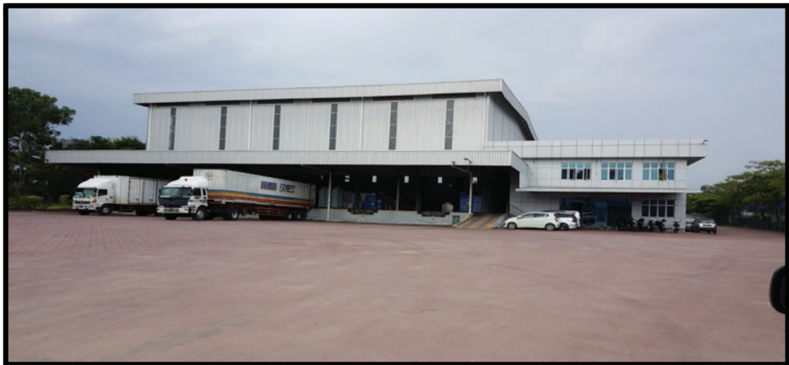
Gambar 26 : Lawatan Input Pembangunan Bagi Pembinaan Rumah Pekerja Di Terminal Berat
