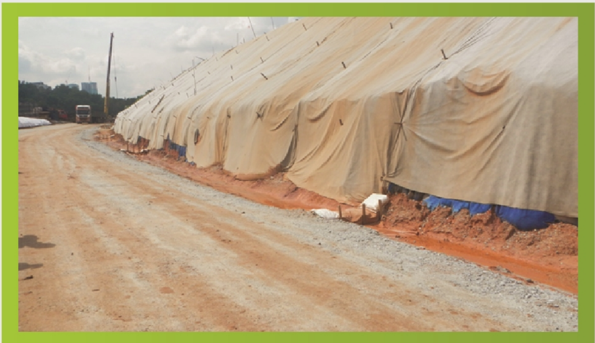
Gambarfoto 7.7 : Gambar plastic cover di kawasan tanah yang terdedah bagi kawalan cerun secara sementara.
