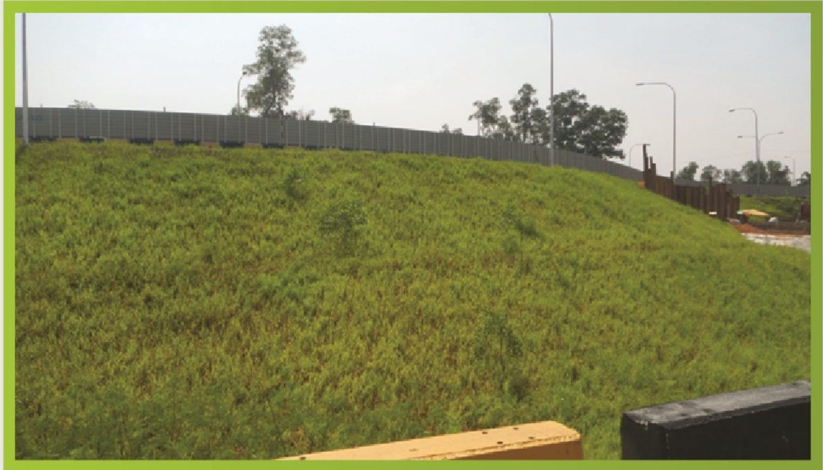
Gambarfoto 7.4 : Gambar menunjukkan “Turfing” di tapak projek sebagai langkah mengawal cerun.
