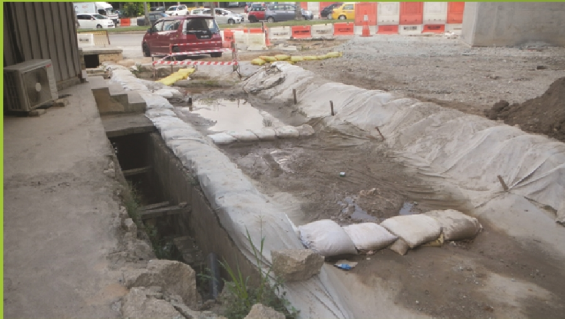
Gambarfoto 7.8 : Gambar menunjukkan “Check Dam” di tapak projek bagi memerangkap sediment dan mengurangkan kelajuan air larian.
