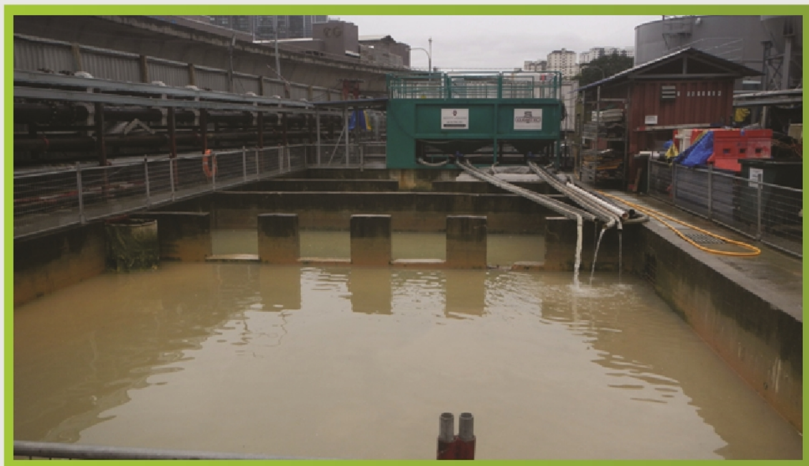
Gambarfoto 7.1 : Gambar menunjukkan Silt Pond & Waste Water Treatment Plant di kawasan projek bagi kawalan pencemaran air.
