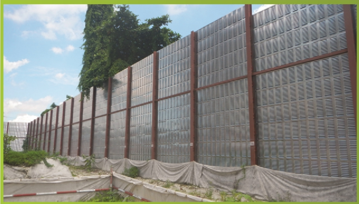
Gambarfoto 7.3 : Gambar menunjukkan Noise Barrier dipasang sebagai langkah kawalan pencemaran bunyi bising
