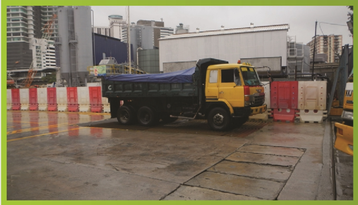
Gambarfoto 7.0 : Gambar menunjukkan di “Wash Trough” kawasan projek bagi mengawal pencemaran sisa tanah di jalanraya
