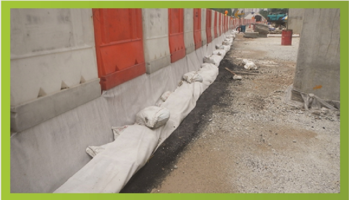
Gambarfoto 7.6 : Gambar Silt Fence & Sand Bag di tapak projek bagi mengawal larian permukaan.
