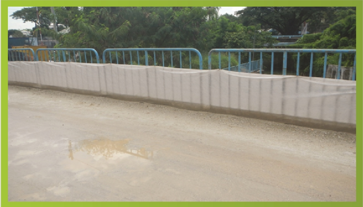
Gambarfoto 7.2 : Gambar menunjukkan Silt Fence dipasang sebagai langkah kawalan larian permukaan.
