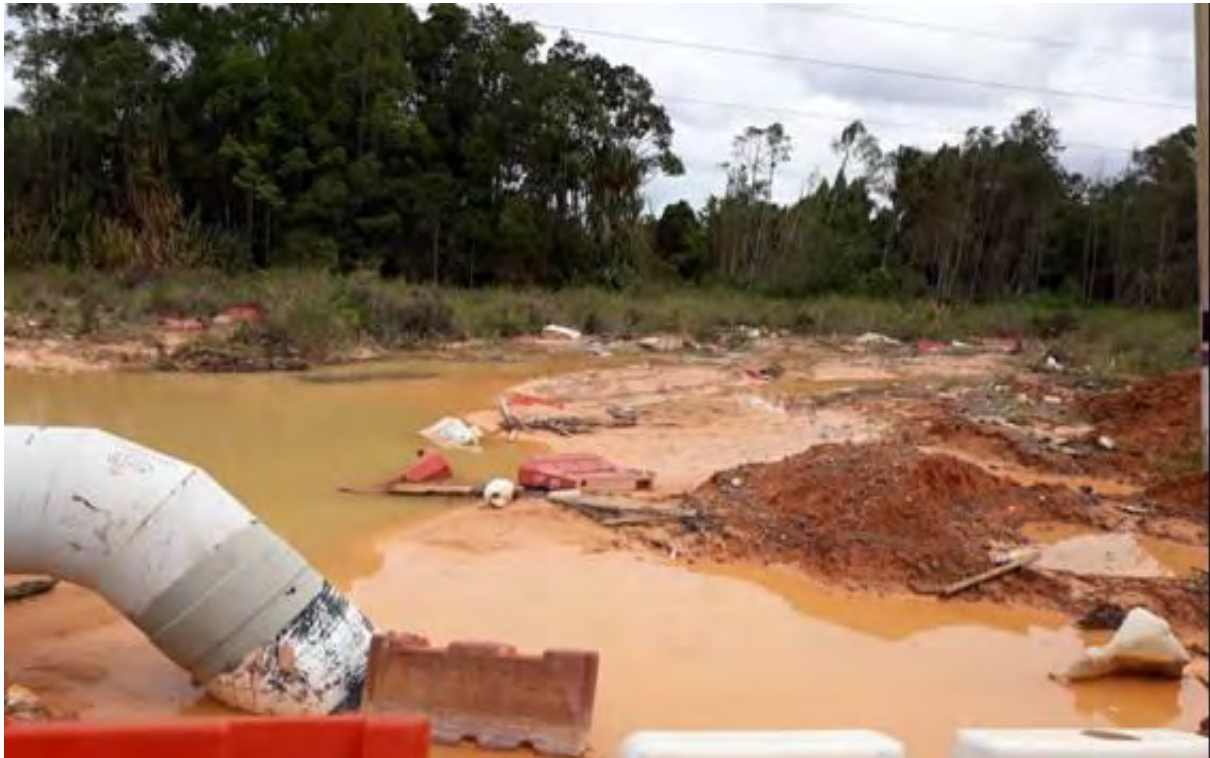
Gambar 3.7 Kota Tinggi, Johor: Tiada penyediaan BMPs di tapak megakibatkan aliran air keruh dan sedimen memasuki alur air berhampiran.
