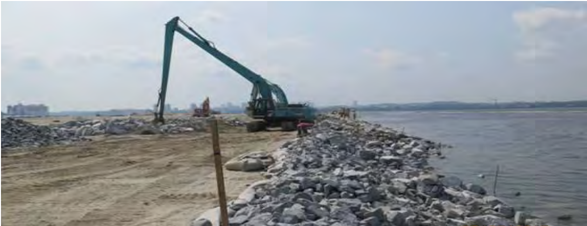
Gambar 3.2 Johor Bahru, Johor: Pemasangan 'rock revetment' di kawasan penambakan. Tirai kelodak dipasang bagi mengelakkan kelodakan melebihi had yang ditetapkan.
