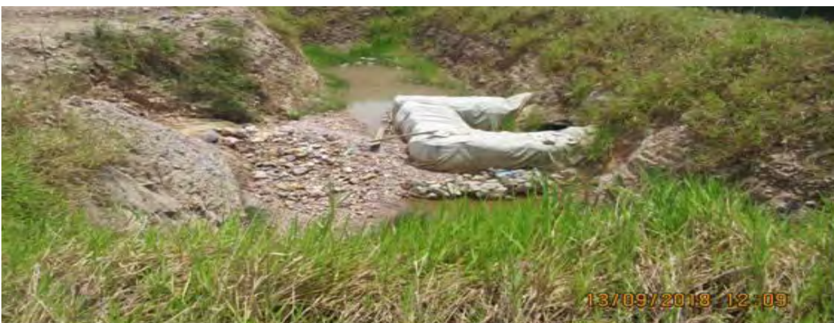
Gambar 3.4 Johor Bahru, Johor: Pembinaan 'Gabion Wall' dilapisi 'Geotextile' bagi mengawal hakisan dan kelodakan daripada terus memasuki alur air.
