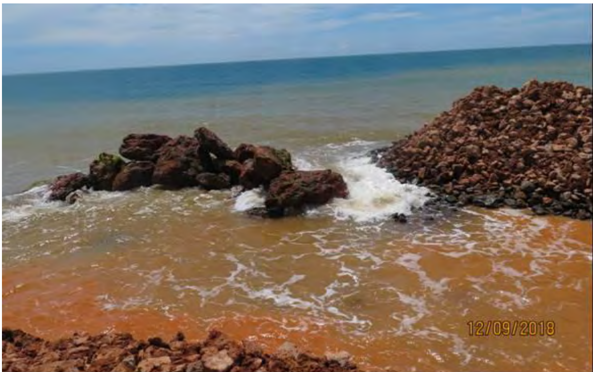
Gambar 3.8 Pengerang, Kota Tinggi: Aktiviti penambakan laut menggunakan tanah merah dan tiada penyediaan tirai kelodak.
