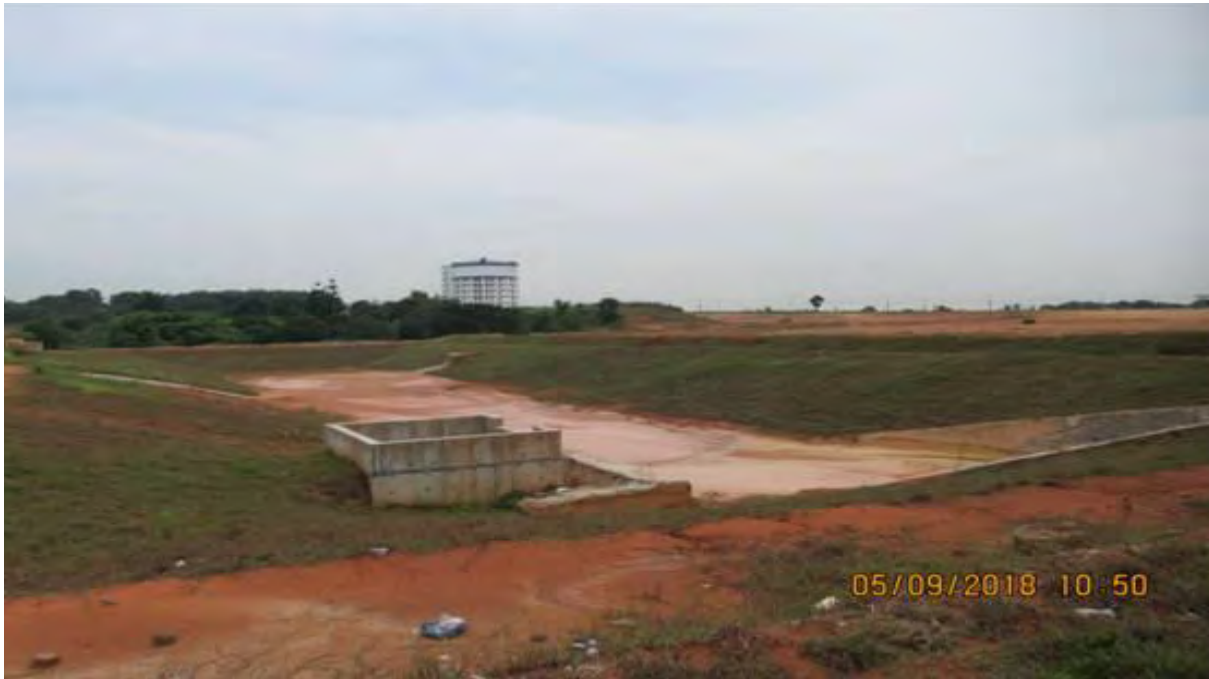
Gambar 3.5 Pasir Gudang, Johor: Aliran air dari tapak projek dialirkan ke kolam perangkap mendap. Cerun kolam perangkap mendap ditanam dengan tanaman tutup bumi serta aliran keluar dari kolam dibina dengan 'gabion wall' yang kukuh.
