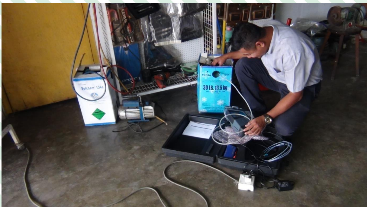
Gambar 2.4 Kelantan : Menunjukkan pemeriksaan Bahan Refrigerant (RI) sedang dilakukan
