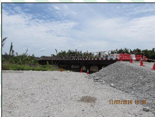
Gambar 3.6 Kelantan: Aktiviti pembinaan jajaran jalan keretapi ECRL.
