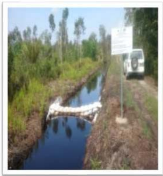
Gambar 2.7 Kelantan : Pembinaan 'check dam' dan tube well untuk meningkatkan paras air.
