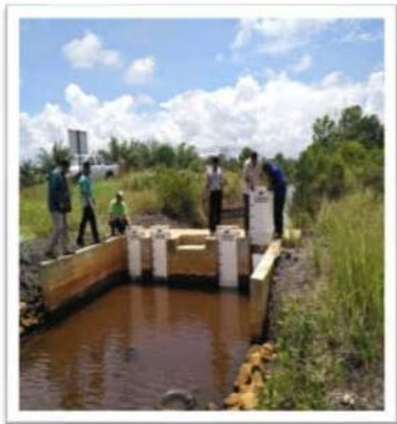
Gambar 2.7 Kelantan : Pembinaan 'check dam' dan tube well untuk meningkatkan paras air.
