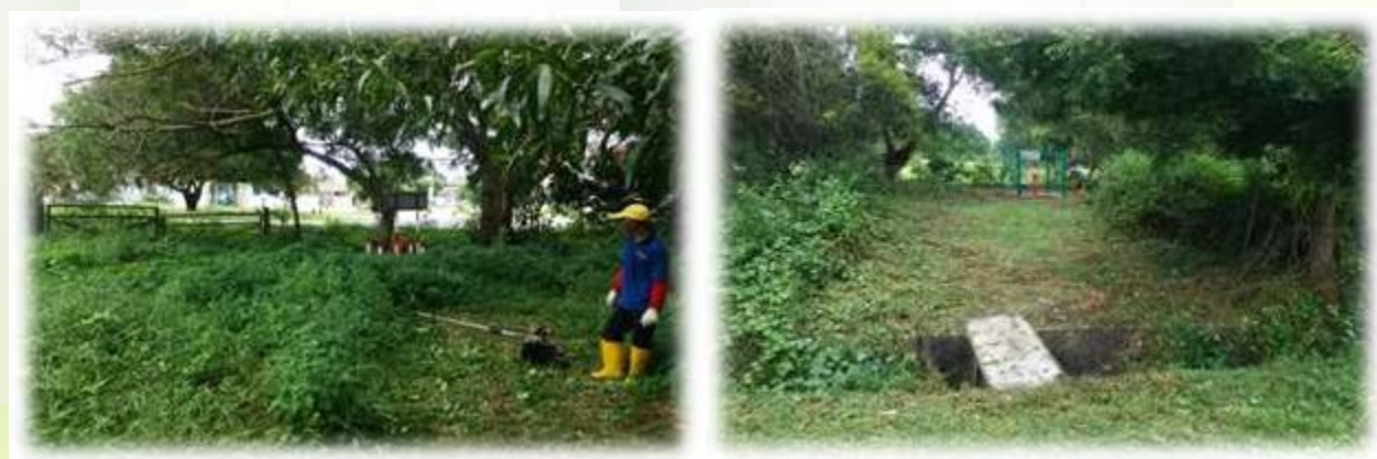
Gambar 2.10 Kelantan : Kerja-kerja Penyelenggaraan Stesen Air Bawah Tanah
