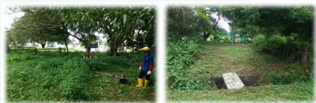
Gambar 3.9 Kelantan : Kerja-kerja Penyelenggaraan Stesen Air Bawah Tanah
