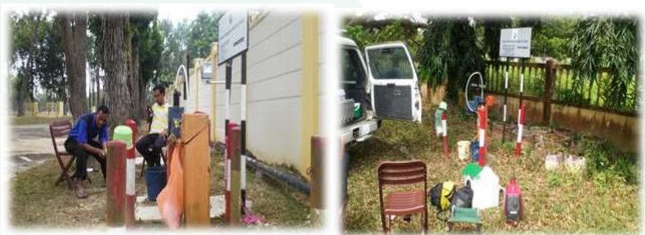
Gambar 3.8 Kelantan : Kerja-kerja Persempelan Kualiti Air Bawah Tanah
