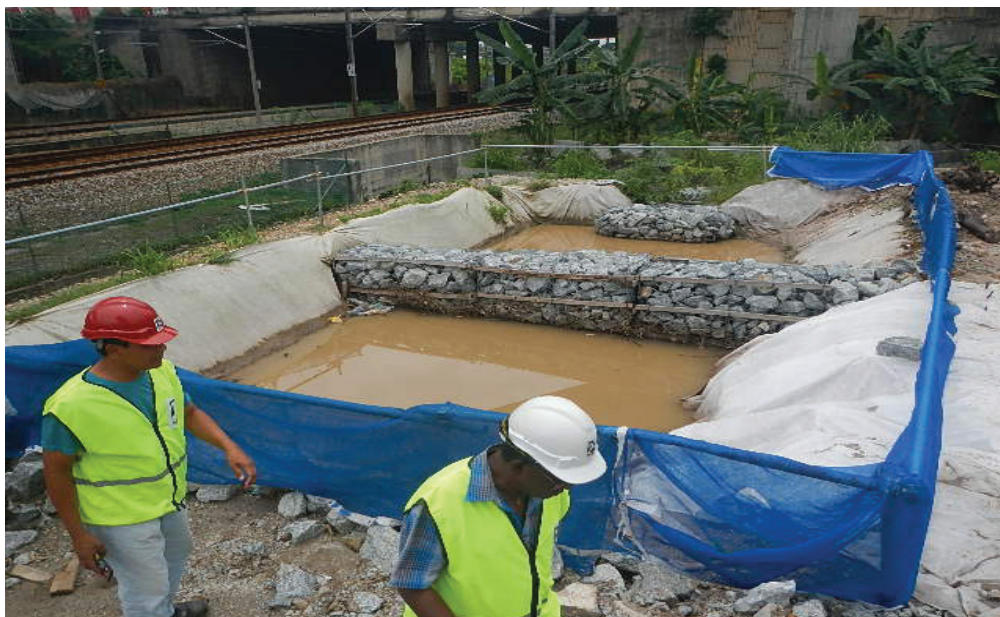
“Silt Trap” di Tapak Projek.
