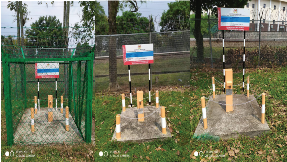
Tiga (3) Stesen Telaga Pemantauan Kualiti Air Bawah Tanah yang terletak di Jalan Sungai Besi
