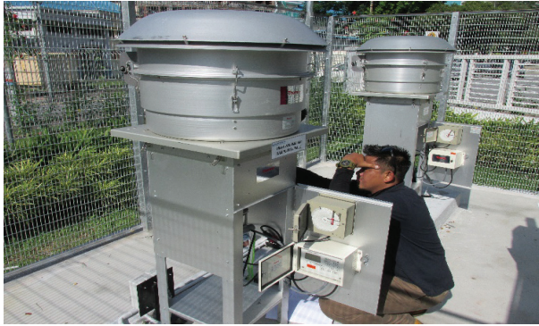
Stesen Udara Manual di Klinik Kesihatan Kuala Lumpur, Wilayah Persekutuan Kuala Lumpur
