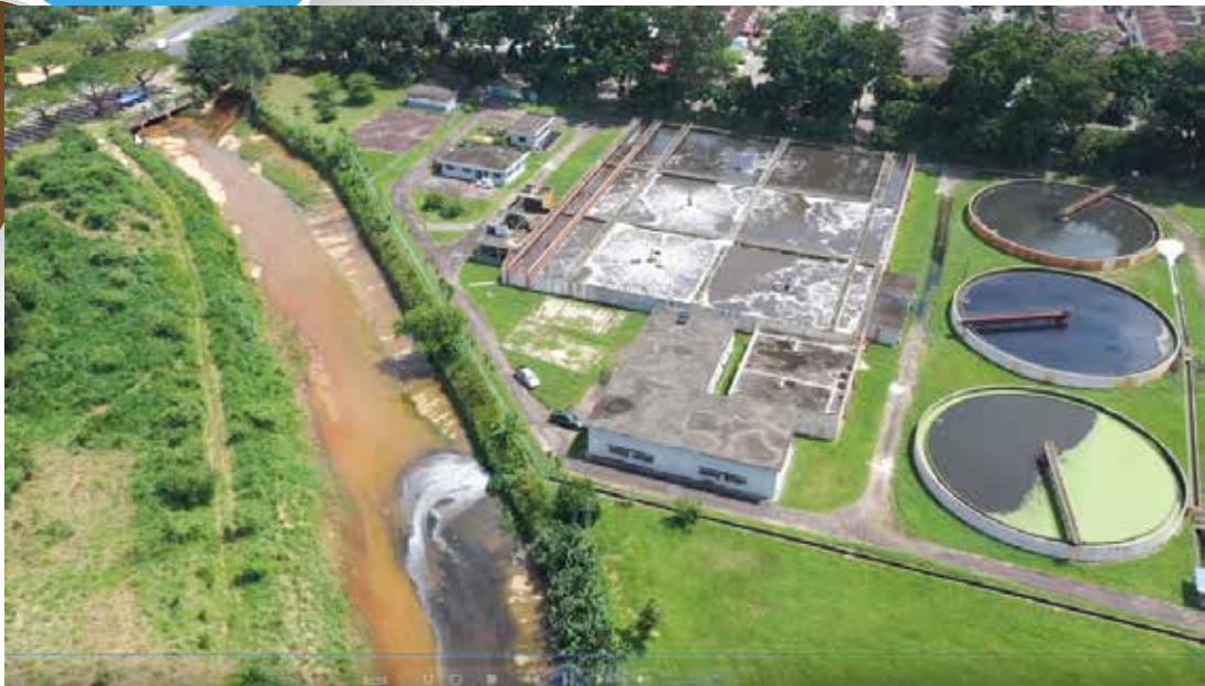
Gambar 8.6 : Pemantauan dan Pengawasan Loji Rawatan Kumbahan menggunakan Dron
