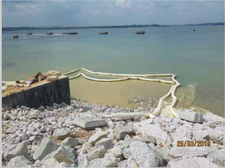
Gambar 3.9 : Pemasangan silt curtain yang betul membantu untuk mengawal kelodakan dari terlepas ke laut lepas di Pasir Gudang
