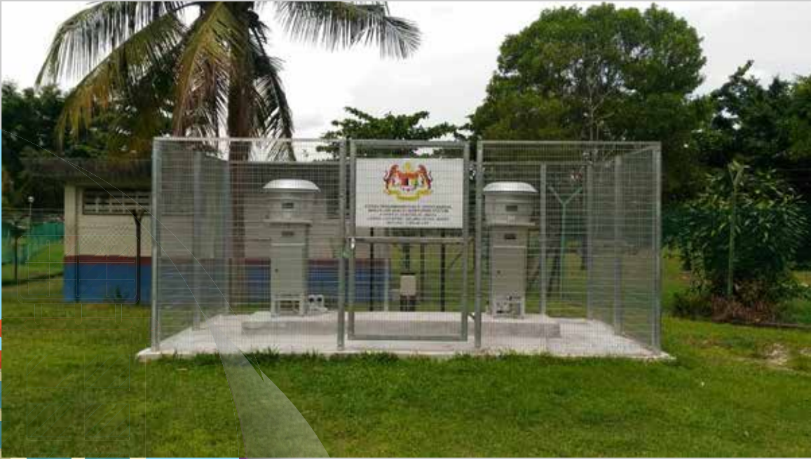
Gambar 6.1: Stesen Pemantauan Kualiti Udara Manual (MAQM) di SMK Gelang Patah, Johor.
