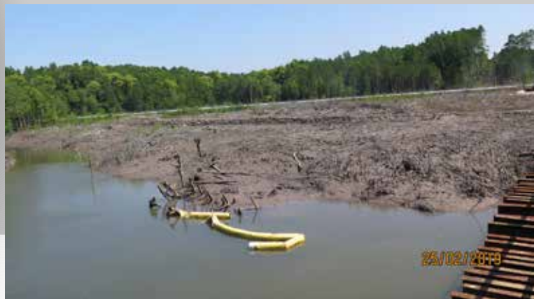
Gambar 3.16 : Tiada penyelenggaraan terhadap silt curtain menyebabkan pencemaran berlaku kepada alur air di Pontian, Johor
