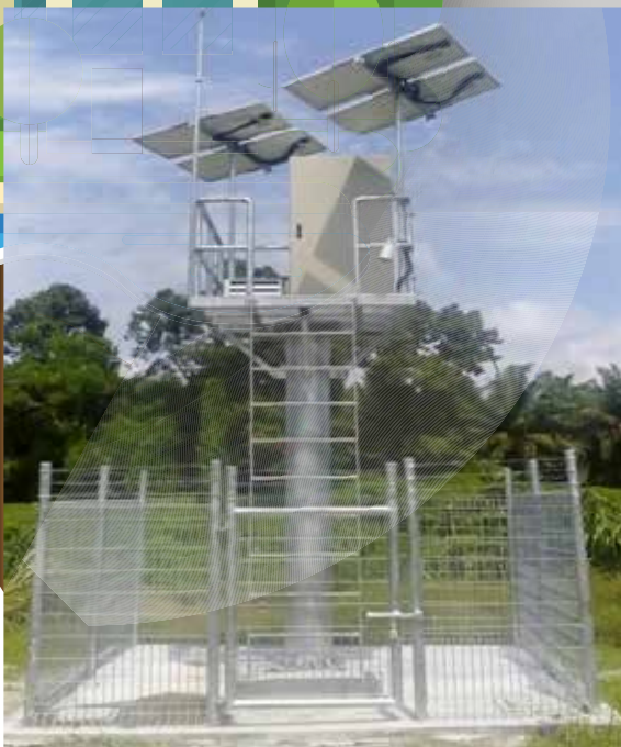
Gambar 6.3 : Stesen pengawasan kualiti air sungai automatik beserta deployment bagi Sungai Skudai (intake Skudai), Johor.
