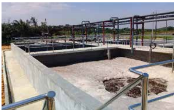
Gambar 9.13 : Kolam Biopolishing dan Takat Pelepasan Akhir yang terdapat di Kilang Kelapa Sawit di Kota Tinggi
