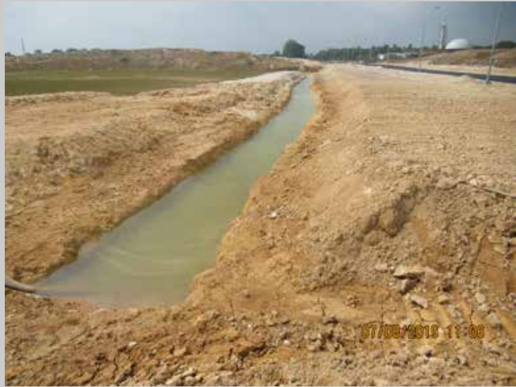
Gambar 3.7 : Pembinaan earth drain di sekeliling perimeter projek bagi mengawal aliran air larian permukaan di Pagoh, Muar
