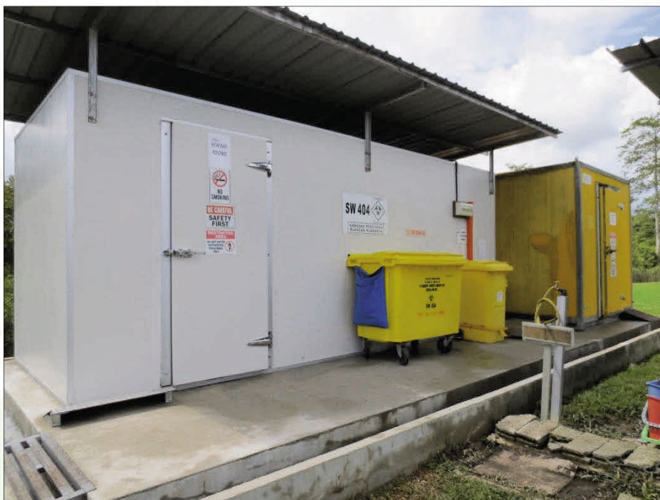
Foto 3.10: Kawasan penstoran buangan terjadual bagi premis hospital / klinik.
