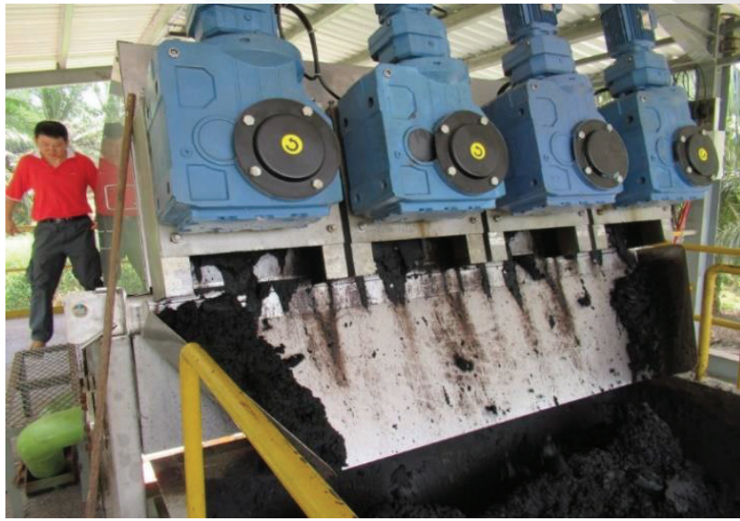
Rajah 34: Kerja-kerja penyingkiran enapemam berterusan dengan kaedah menggunakan Filter Press.
