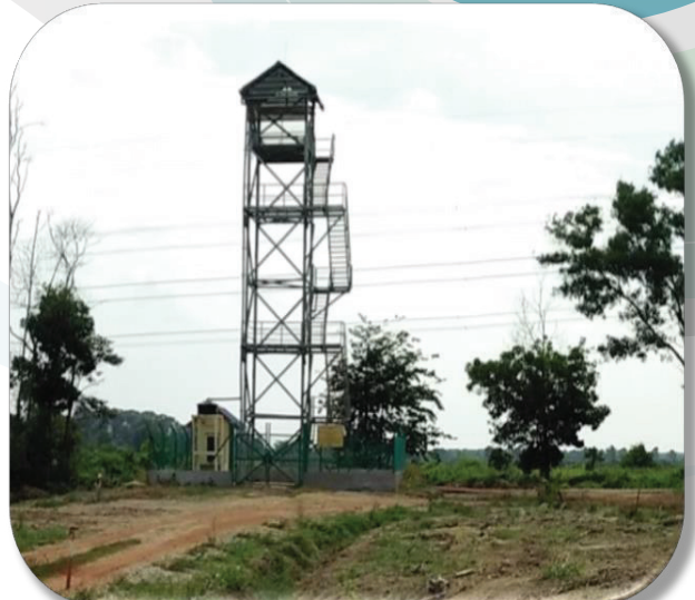
Rajah 48: Infrastruktur Menara Tinjau
