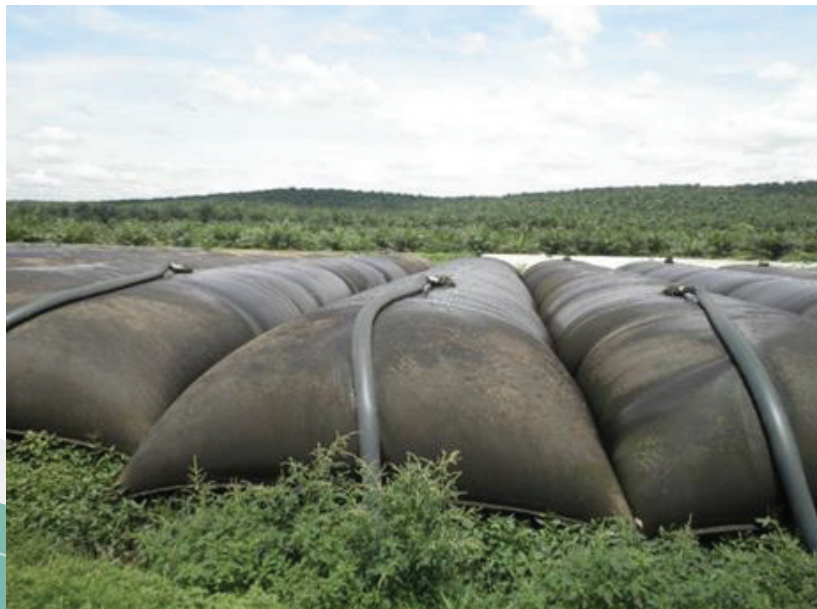
Rajah 35: Kerja-kerja penyingkiran enapemam berterusan dengan kaedah menggunakan Geotube
