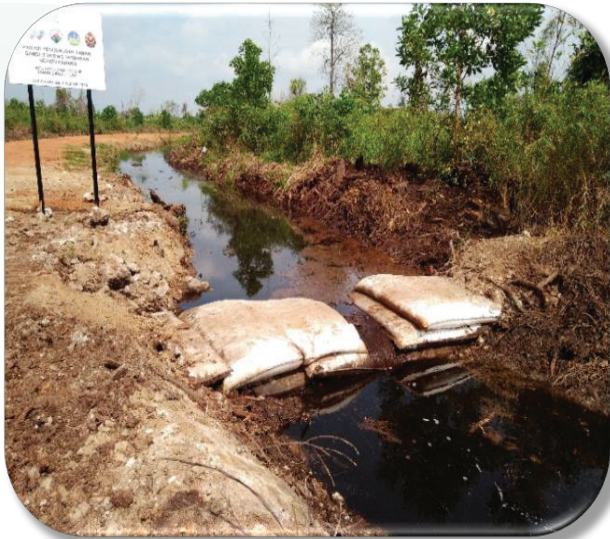
Rajah 46: Infrastruktur Sekatan Saliran (Check Dam)
