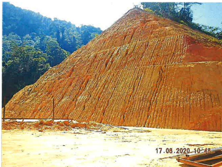
Gambar 14: Semua permukaan tanah yang dibuka tidak dibuat penstabilan sementara mahu pun ditutup dengan tanaman tutup bumi.
