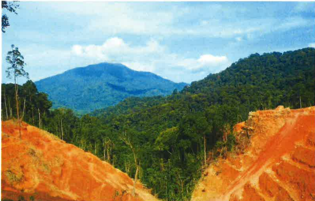
Gambar 6: Tiada penstabilan cerun, cerun-cerun dibuat terlalu curam
