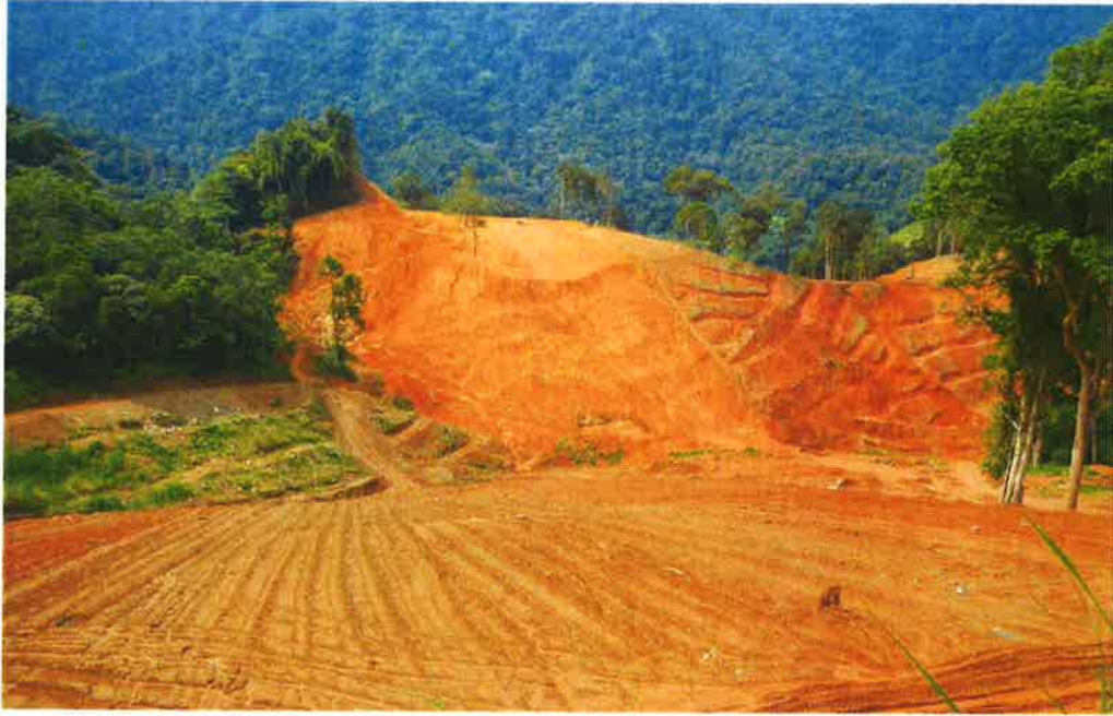
Gambar 7: Tiada penstabilan cerun, cerun-cerun dibuat terlalu curam
