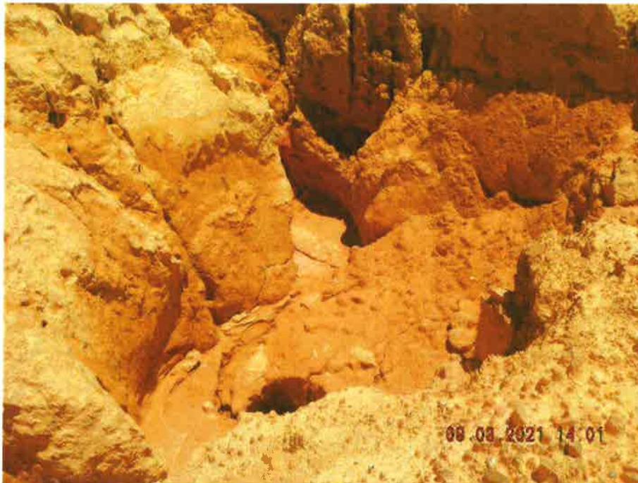
Gambar 27: Hakisan Gully yang terbentuk diserata kawasan kerja tanah yang ditinggalkan.
