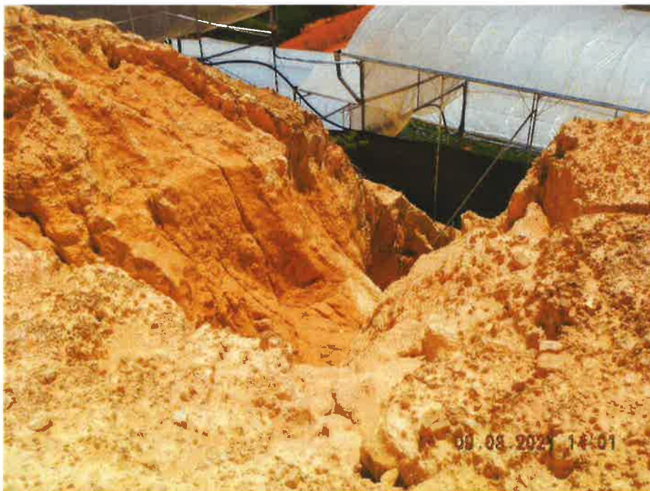
Gambar 26: Hakisan Gully yang terbentuk di kawasan kerja tanah yang ditinggalkan.
