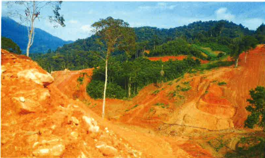
Gambar 4: Tiada Kolam Kelodakan disediakan, kelodakan terus memasuki alur air
