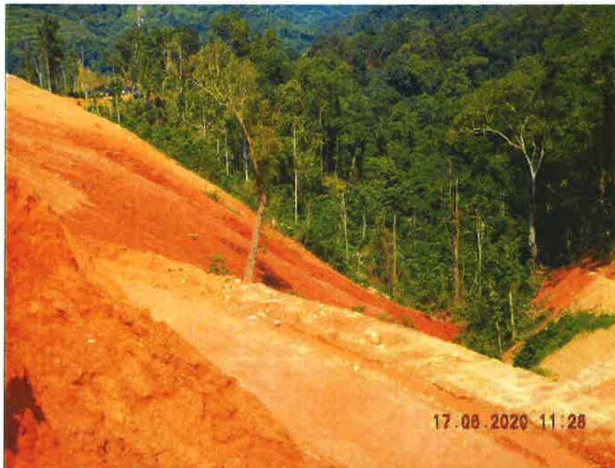
Gambar 17: Overburden dari kerja-kerja tanah tidak diuruskan dengan betul dan ditolak terus ke kawasan cerun yang di bawahnya terdapat alur air yang terus menumbus alur-alur air.
