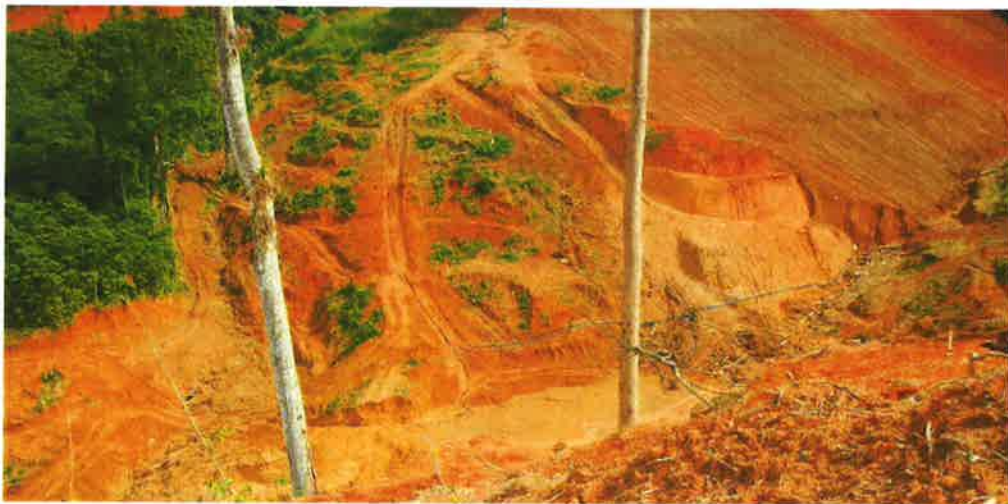
Gambar 8: Overburden tidak diuruskan dengan betul dan ditolak menimbus alur air
