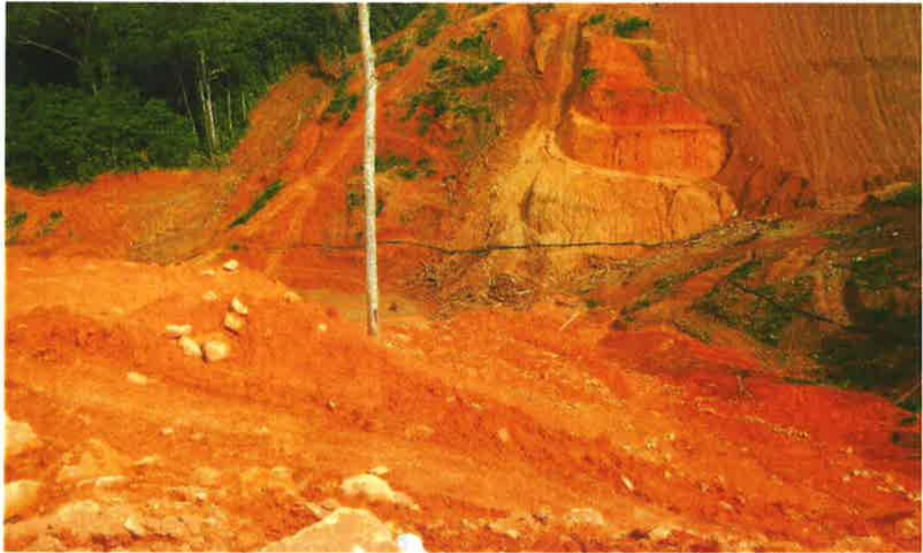
Gambar 5: Tiada Kolam Kelodakan disediakan, kelodakan terus memasuki alur air
