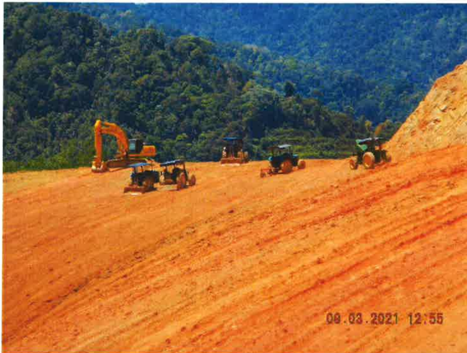
Gambar 24: Permukaan cerun yang tidak ditanam dengan tanam tutup bumi mengalami hakisan rail dan gully serius.
