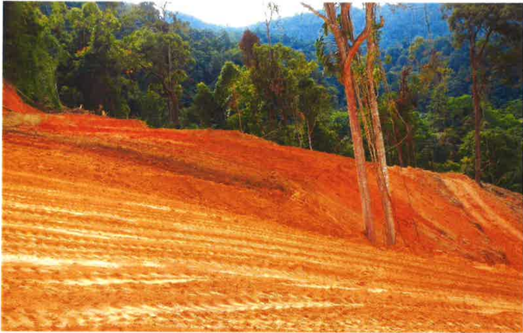
Gambar 4: Tiada Kolam Kelodakan disediakan, kelodakan terus memasuki alur air
