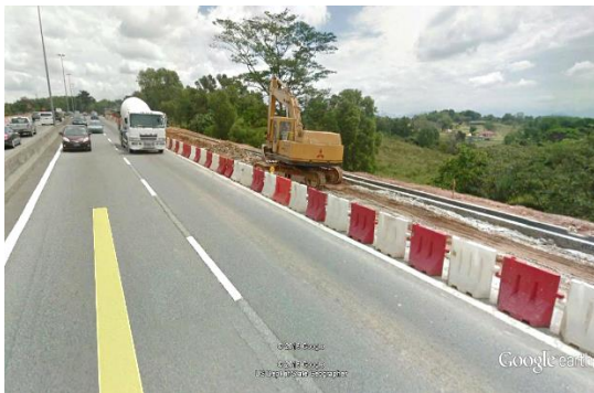
No.3-Pemandangan di Jalan Sungai Besi yang terletak 630m ke arah barat kawasan projek.
