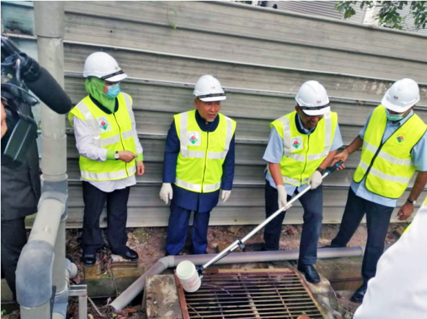
Ops Gempur yang Disertai YBM KASA dan YBhg. KSU KASA Ops Gempur accompanied by YBM KASA and YBhg. KSU KASA
