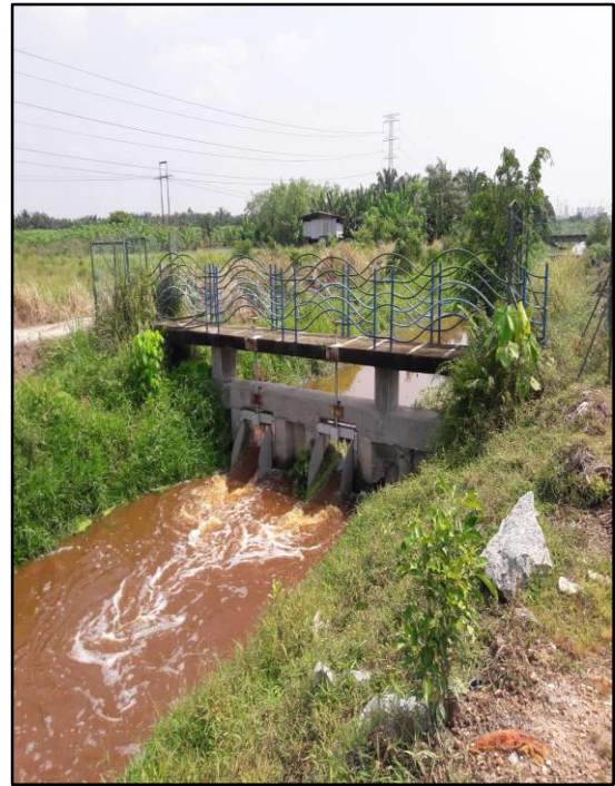
Foto 4.13: Check dam yang dibina di kawasan fire prone di Negeri Selangor
