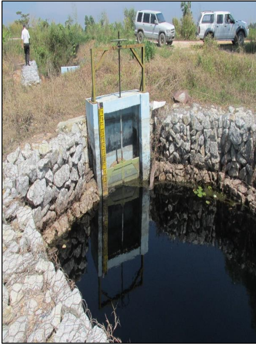
Foto 4.13: Check dam yang dibina di kawasan fire prone di Negeri Selangor
