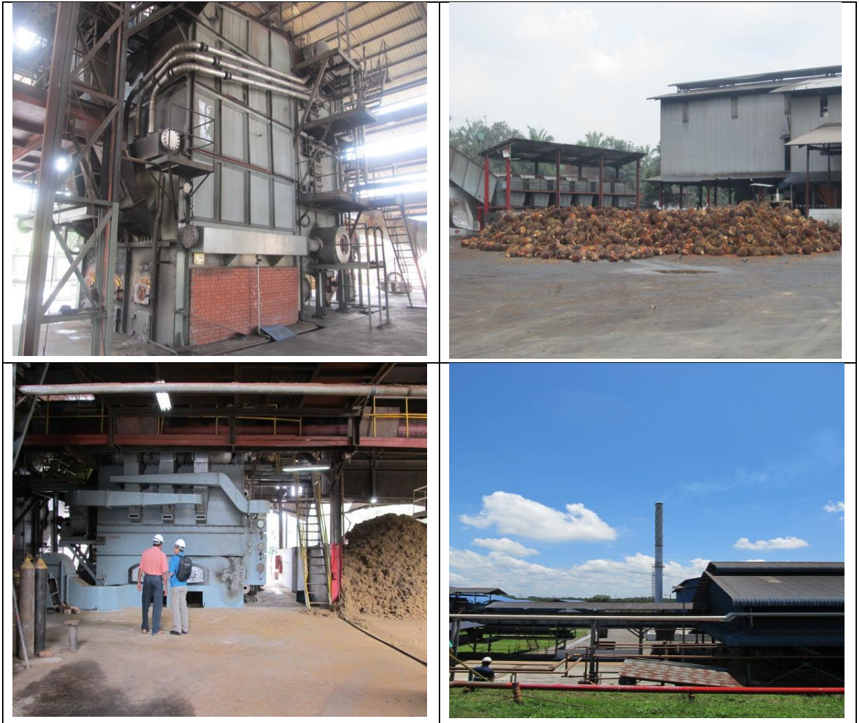
Foto 4.4 : Kerja-Kerja Penguatkuasaan Ke Atas Kilang Kelapa Sawit Di Negeri Selangor, Tahun 2020
