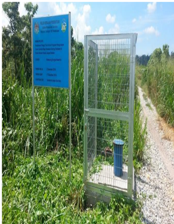
Foto 4.15: Tube well yang dibina di kawasan fire prone di Negeri Selangor
