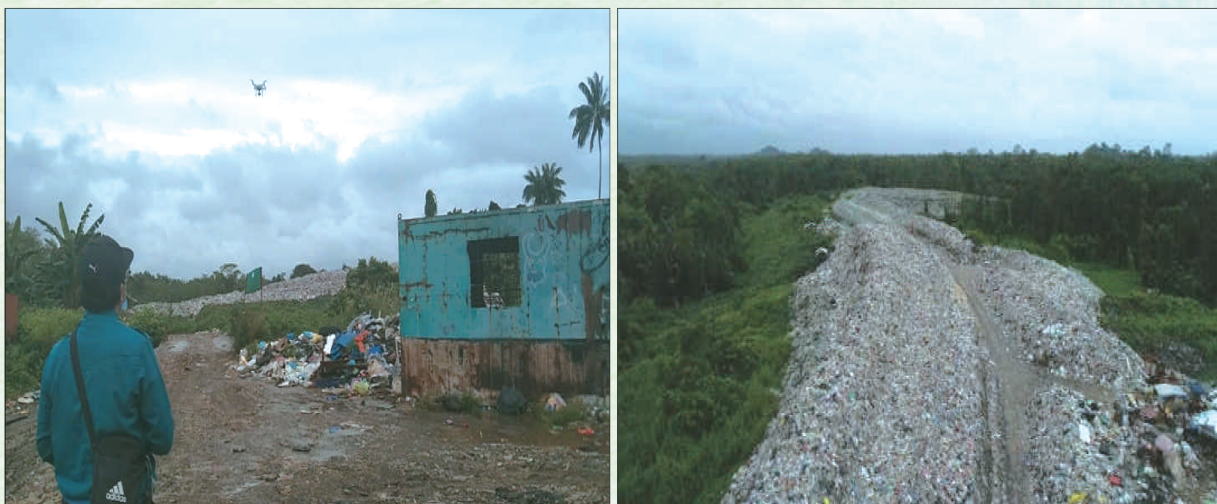
Foto 3.11: Gambar pemantauan melalui udara ( drone ) pada tahun 2020
