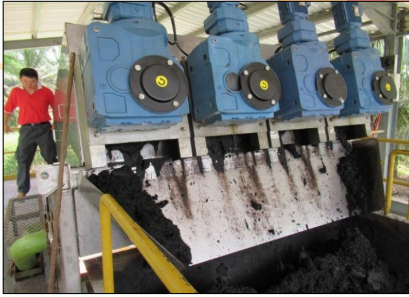
Rajah 35: Kerja-kerja penyingkiran enapcemar berterusan dengan kaedah menggunakan Filter Press.
