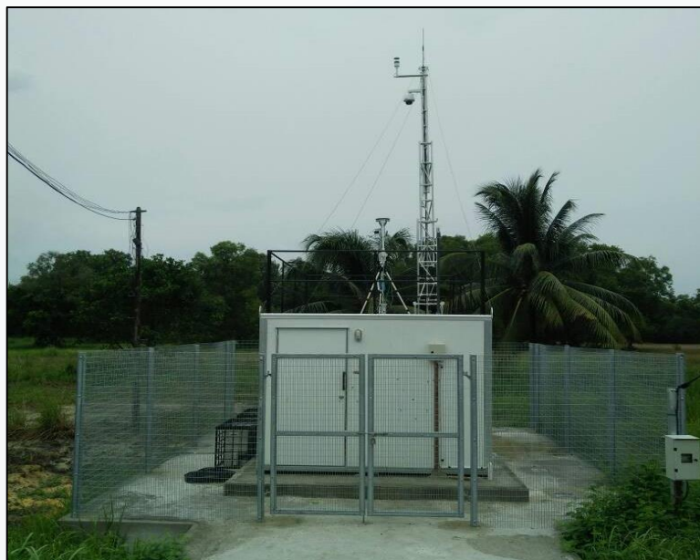
Rajah 24: Stesen udara di Balok Baru, Kuantan.
