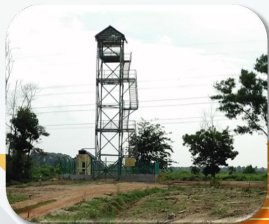
Rajah 49: Infrastruktur Menara Tinjau.
