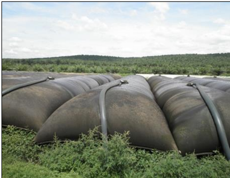
Rajah 36: Kerja-kerja penyingkiran enapcemar berterusan dengan kaedah menggunakan Geotube.
