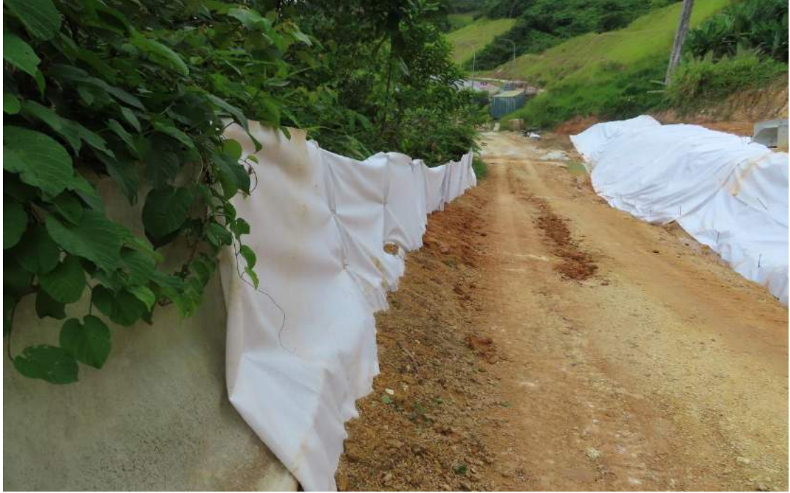
Foto 28 : Gambar menunjukkan pemeriksaan "silt fence".
