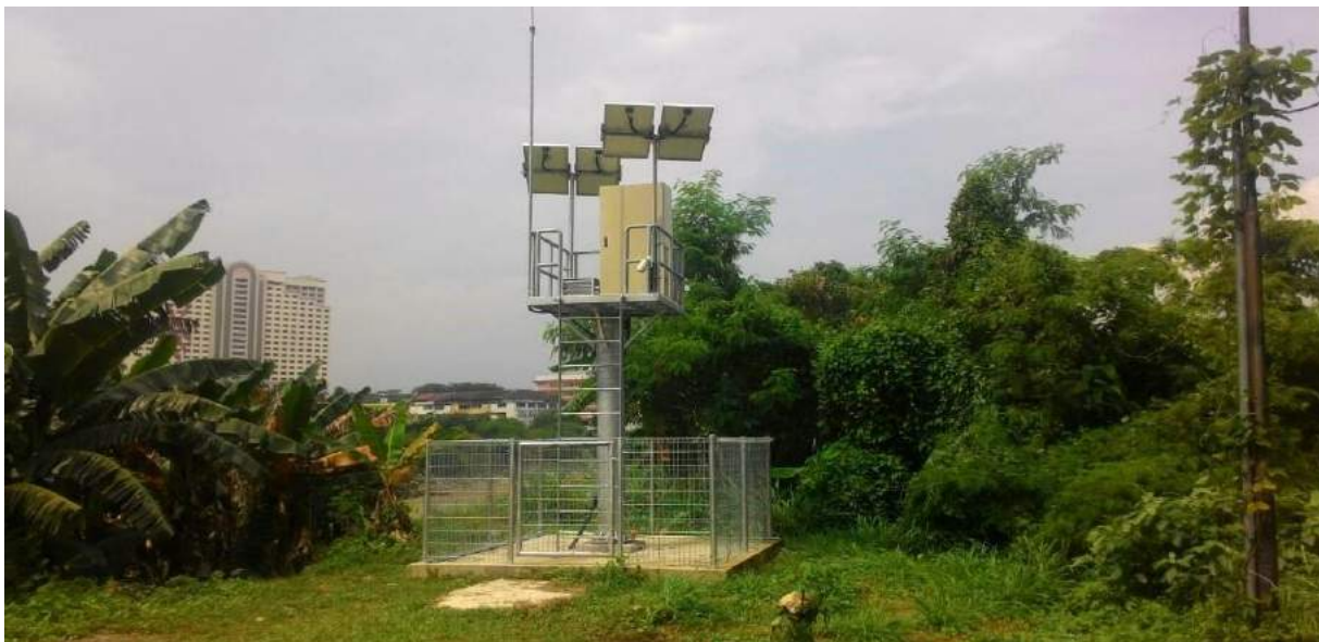
Foto 44 : Stesen Pengawasan Air Sungai Automatik
