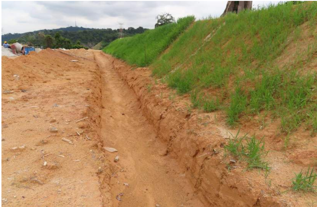
Foto 26 : Gambar menunjukkan pemeriksaan “earth drain”.
