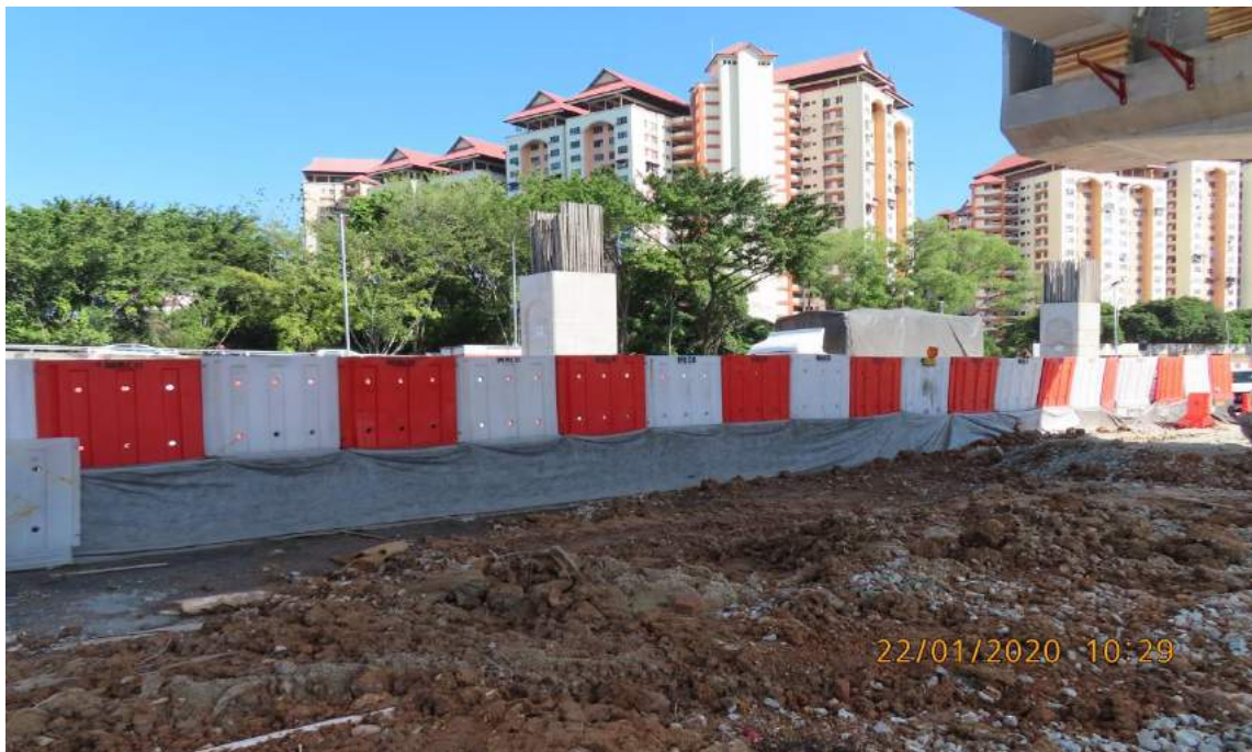
Foto 20 : Gambar menunjukkan pemeriksaan “silt fence” di tapak projek.
