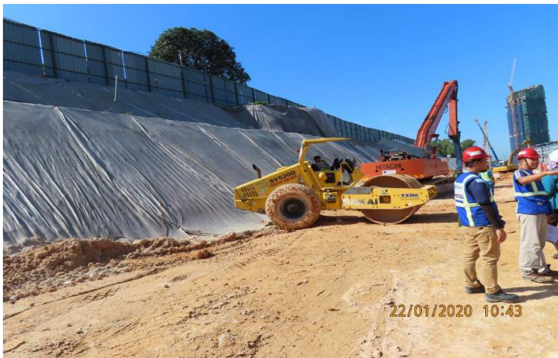
Foto 21 : Gambar menunjukkan pemeriksaan “Slope Protection”.
