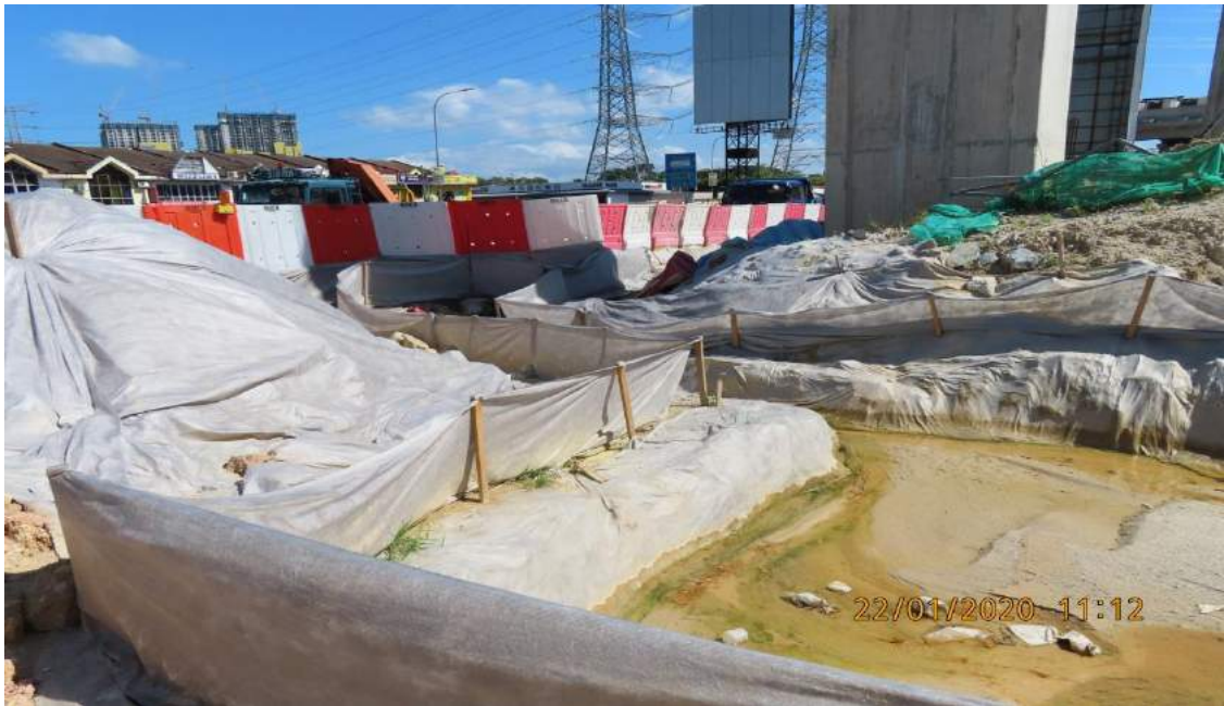
Foto 22 : Gambar menunjukkan pemeriksaan “Silt Trap” di tapak projek.
