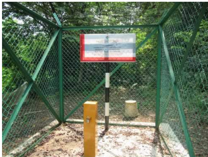
Foto 33 : 1 Stesen Telaga Pemantauan Kualiti Air Tanah yang terletak di Taman Wetland, Putrajaya
