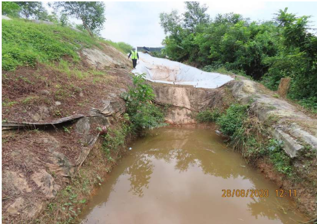
Foto 24 : Gambar menunjukkan pemeriksaan "silt trap".
