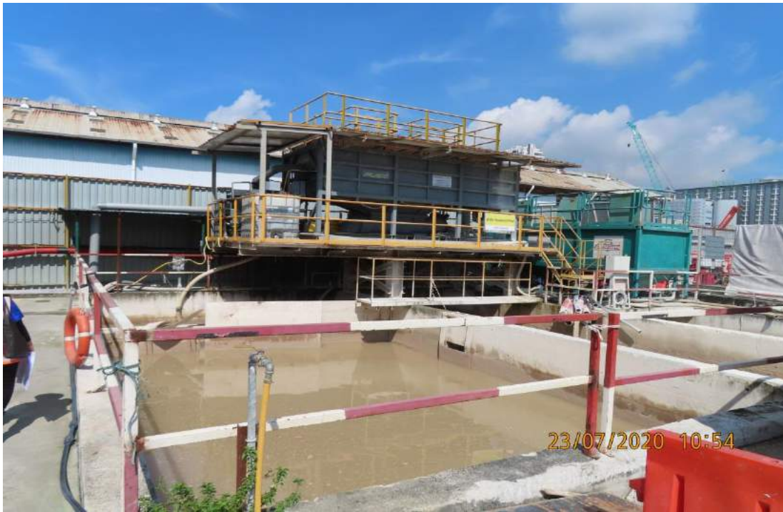
Foto 16 : Pemeriksaan “Silt Pond & Waste Water Treatment Plant” di kawasan projek.
