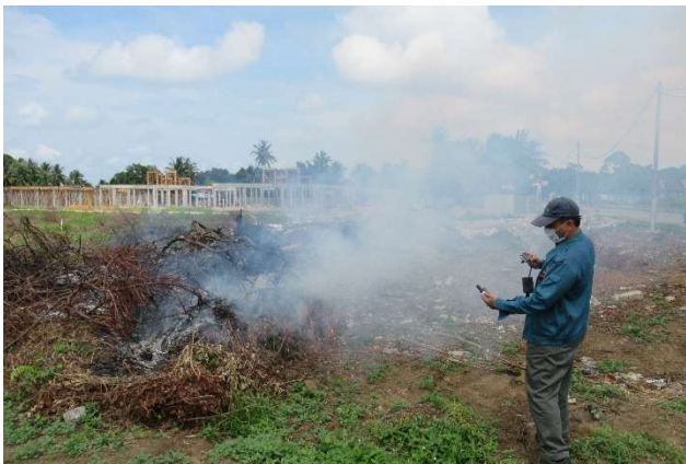
Gambar 10: Aduan Pembakaran Terbuka di Tapak Pembinaan Bukit Rambai
