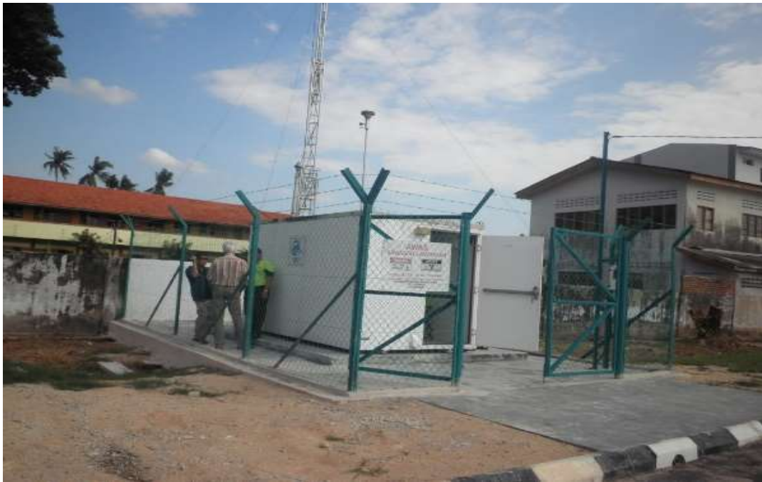
Gambar 35: Stesen Pengawasan Kualiti Udara Automatik, Sekolah Menengah Tinggi Melaka
